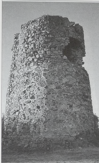
Torre de Guadiaro (Mamilva)
