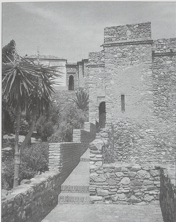
La limpieza restauradora afecta también a los enfoscados
