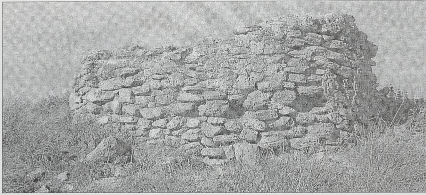
Foto nº 6 Torre del Cuchillo. Antequera
