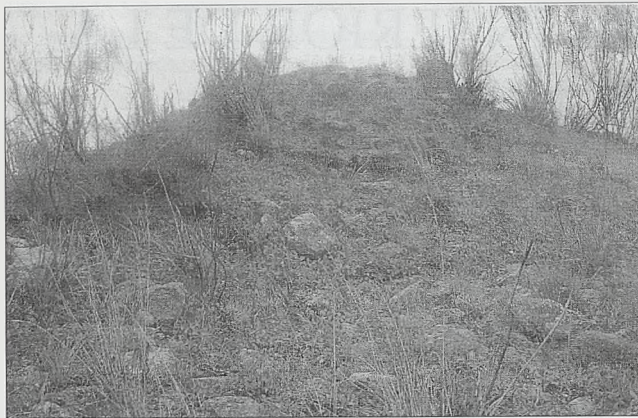
Foto nº 2 Torre de Cantarraján. Almogía
