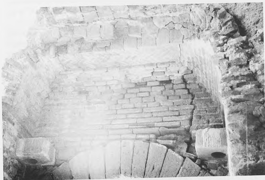
Foto 5.- Interior del cubo de ingreso.
