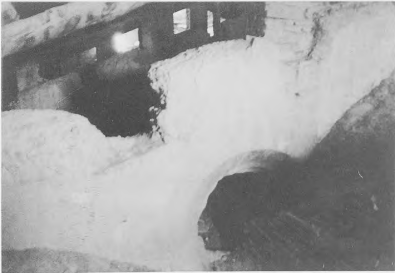
Fig. 19.- Arcos y vigas de la mezquita original (Torrellas)
