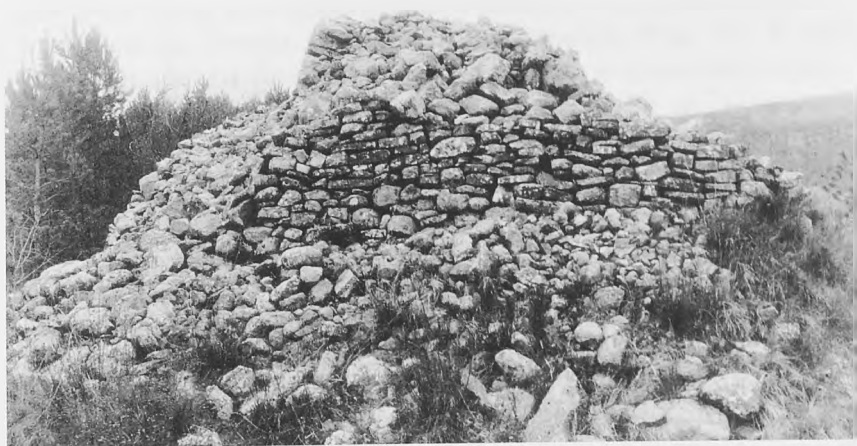
Foto 8.- Torreón 4. Se aprecian los dos niveles constructivos.
