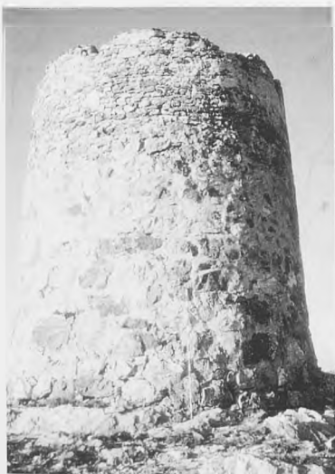
Foto 2. Atalaya del Puerto de Yébenes (Los Yébenes, Toledo). Obsérvese a diferente fábrica del tercio superior fruto de la reutilización como molino de viento.
