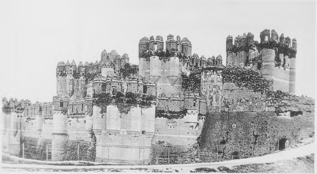
Fot. 3.- La fortaleza construida por la familia Fonseca en la segunda mitad del siglo XV. En la zona derecha se observa su entronque en la muralla urbana.
