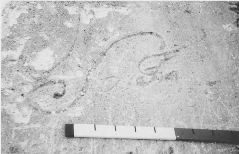
Fig. nº 3.- Firma en el mortero fresco del último revoco. Fuerte de San Sebastián en Castro Marín. (Ascensión Ferrer, 1994).
