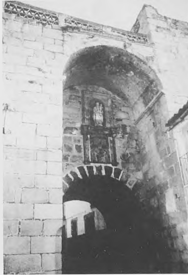
Fig. 12.- Puerta con una sola torre lateral, arco de medio punto con rosca gruesa y restos de defensa vertical (Puerta "B", Coria, Cáceres).
