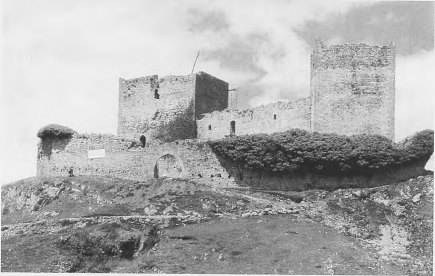
Foto 1. Castillo de Argüeso (antes de su restauración)
