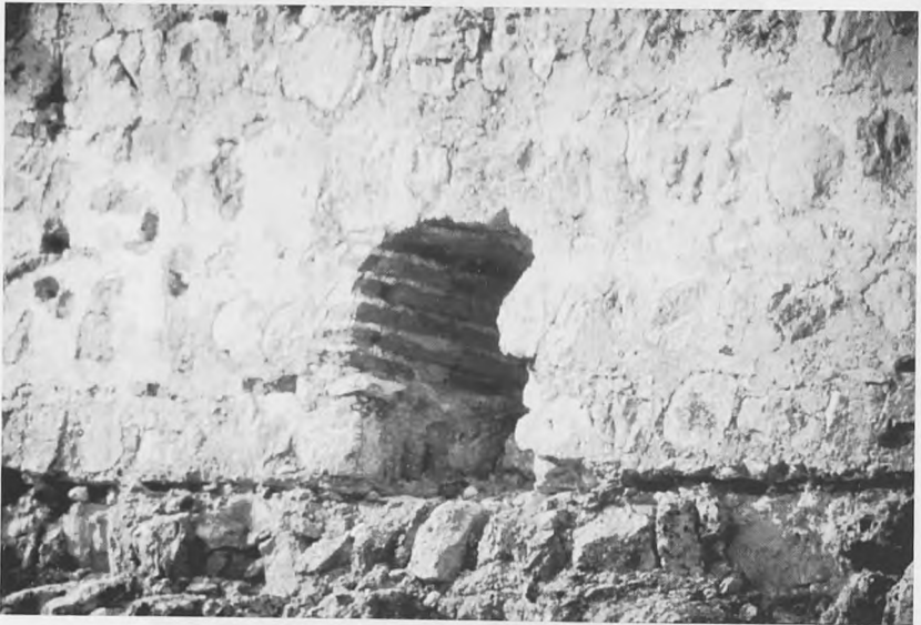
Fig. 39.- Saeteras en ladrillo (Gormaz "A", Soria)
