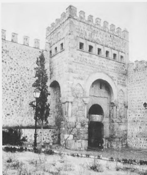
Fig. 14.- Puerta compleja, con buhardas frontal y lateralreconstruidas en el siglo XIV. Se observa portillo adintelado cegado a la derecha, así como dintel de refuerzo (Puerta Vieja de Bisagra, Toledo).
