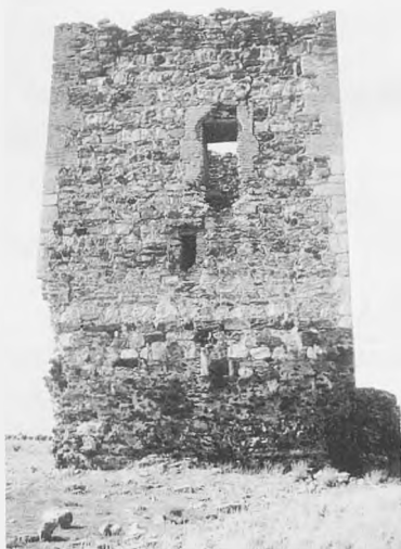
Foto 1. Torre de Azuqueca (Consuegra, Toledo). Lienzo SO., donde destaca la amplia ventana con arco de herradura.
