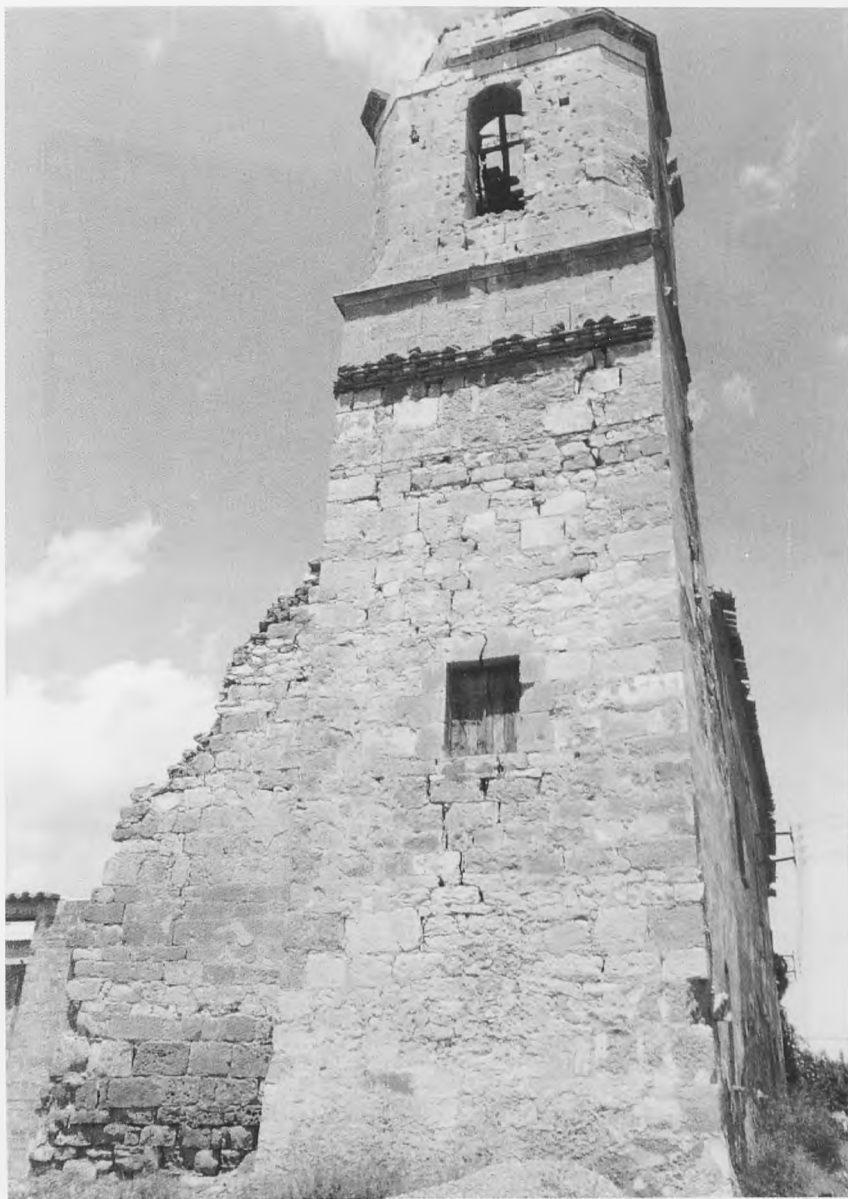
Fig. 8.- Torre del Convento de Escarpe.
