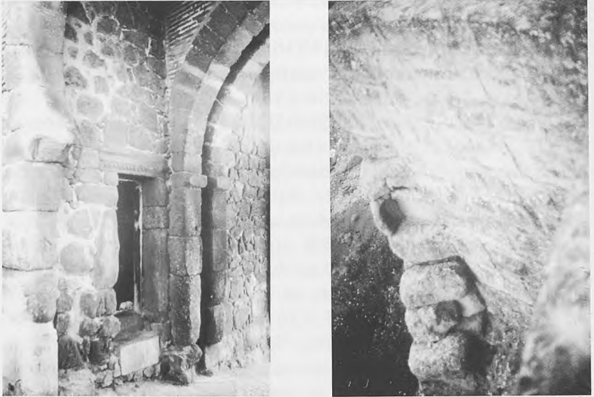
Fig. 1.- Detalle de portillo de acceso a puerta adintelada de acceso a buharda con utilización de "spolia" en el dintel. (Puerta de Mu`awiyya o del Sol, Toledo).
