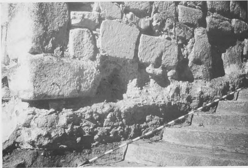
Fig. 3.- Enripiado (Maqueda, Toledo).
