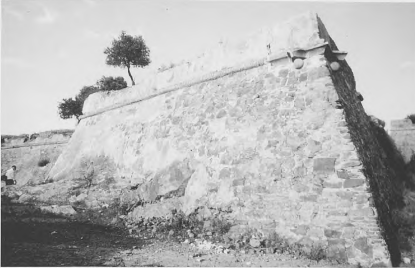
Fig nº 2.- Bastión sureste del Fuerte de San Sebastián en Castro Marín. Se pueden observar las distintas fábricas: mampuesto, ladrillo y el uso de la piedra viva sin tallar aprovechada en el pie de la construcción. (Ascensión Ferrer, 1994).
