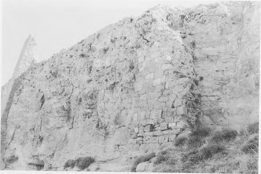
Fig. 16.- Cimientos de torres rectangulares (Borja)
