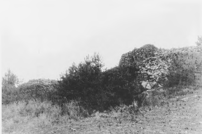
Foto 4.- Los torreones 1(a la derecha) y 2(a la izquierda), desde la parte superior de la terraza defensiva sur.
