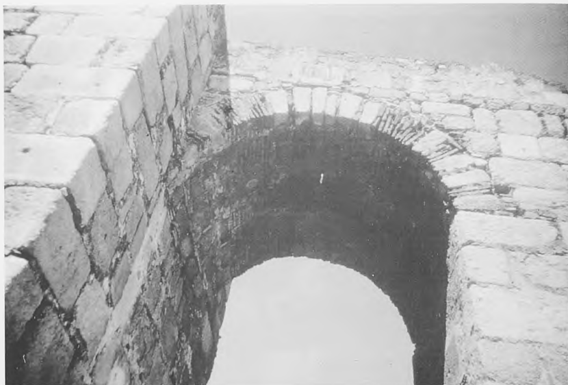
Fig. 4.- Puentecilla de torre de albarraña, mostrando a) enjarje con muro, b) construcción en ladrillo y b) uso de defensa vertical mediante machiculis (835 d.C.) (Alcazaba de Mérida, Badajoz).
