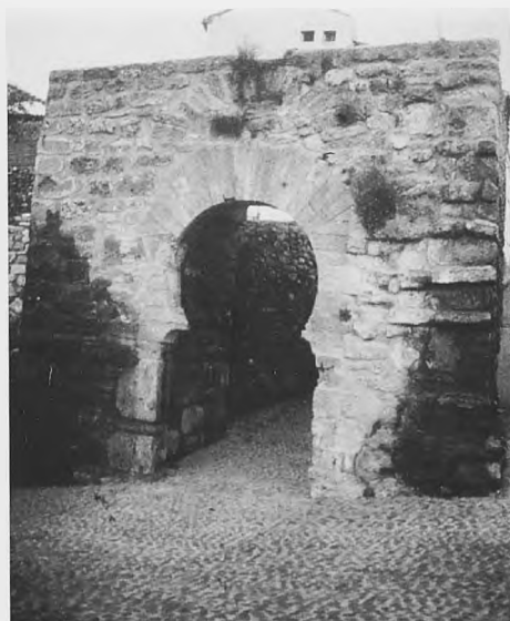
Fig. 15.- Puerta en codo simple con restos del enjarje del antecastellum a la derecha. Se aprecia claramente el arco de descarga. (Puerta "A" de Agreda, Soria)
