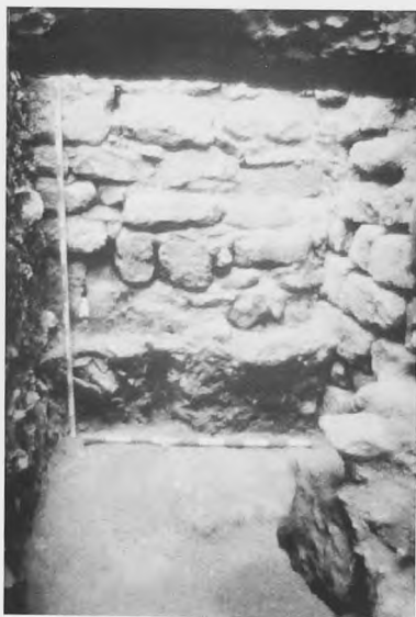
Lám. 2.2: Corte 5. Detalle de los cimientos de la Torre de los Leones.
