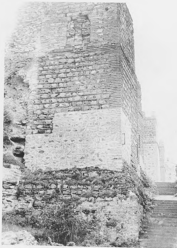
Foto 4.- Torre del Castillo de Buitrago de Lozoya (Madrid).
