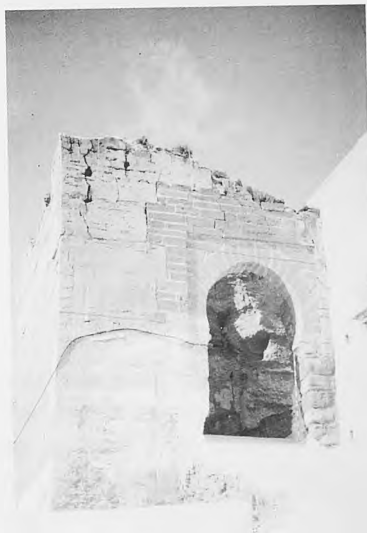
Foto 4.- Puerta de ingreso
