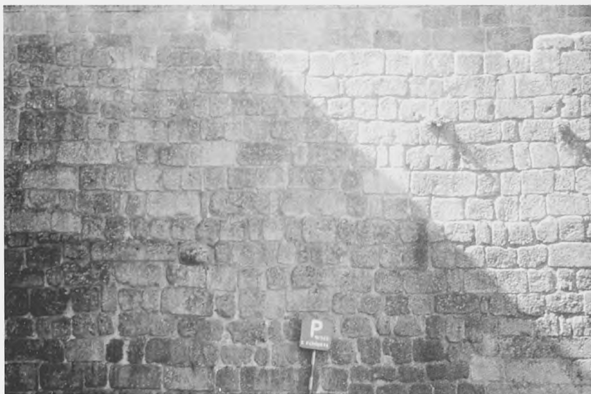
Fig. 5a.- Aparejo de hiladas regulares (Viseu, Portugal).
