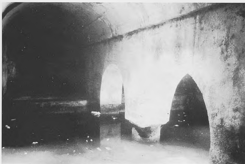
Fig. 47.- Cisterna ((Trujillo "B", Trujillo, Cáceres)
