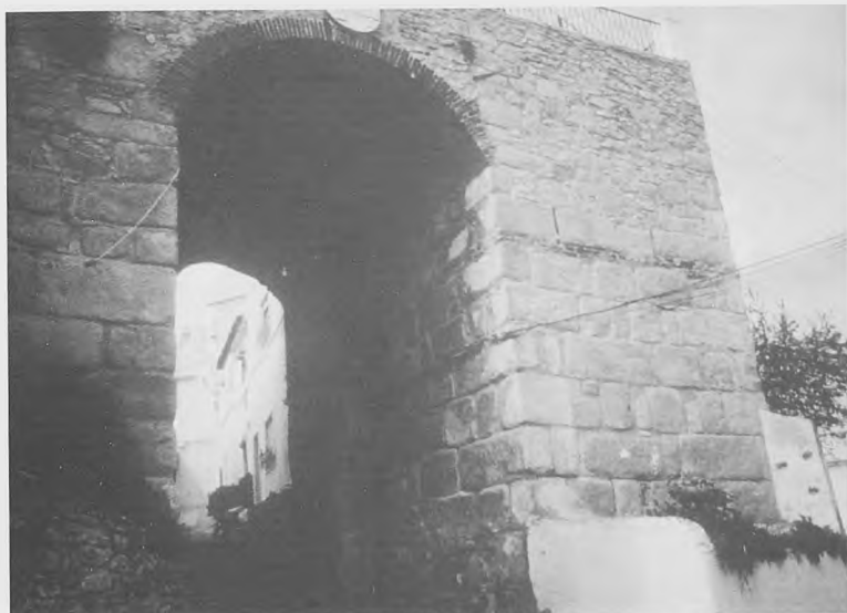
Fig. 5b.- Vista frontal, mostrando aparejo, de la Porta do Miradeiro (Elvas, Portugal).
