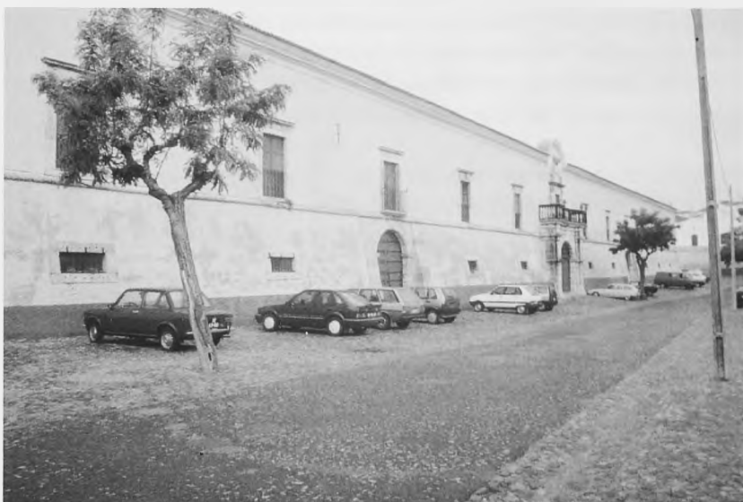
Fig. nº 7.- Edificio en el recinto interior del Castillo de Elvás. Se ha intentado restaurar con el color ocre amarillo original. (Ascensión, Ferrer 1994).
