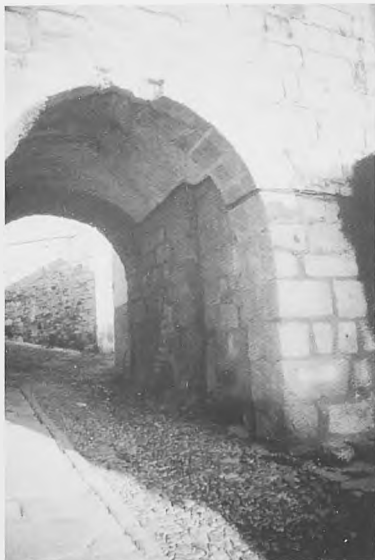
Fig. 10.- Puerta arcáica, con arco de medio punto, rosca gruesa. (Arco del Cristo, Cáceres).
