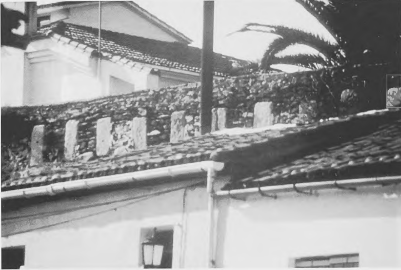
Fig. 40.- Ejemplos de almenas prismáticas, arcácias embutidas en muro posterior. (Coria, Cáceres)
