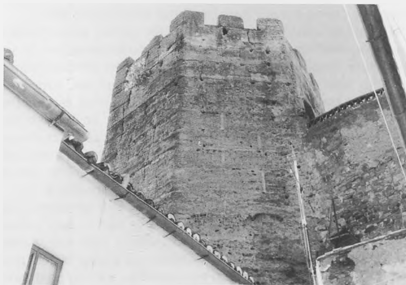
Fig. 2: Torre albarra de las defensas de Cáceres. Restos del enlucido.
