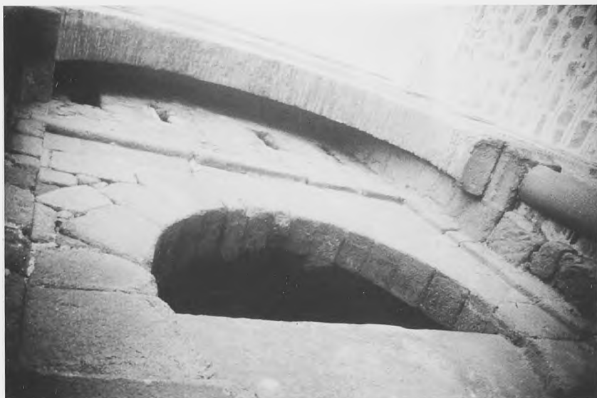
Fig. 23.- Detalle de buhareda rasgada reconstruida. (Puerta Vieja de Bisagra, Toledo).
