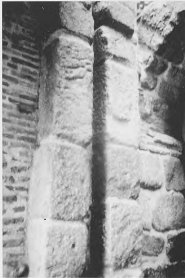
Fig. 25.- Ranurado de "porticulis" (Maqueda, Toledo).
