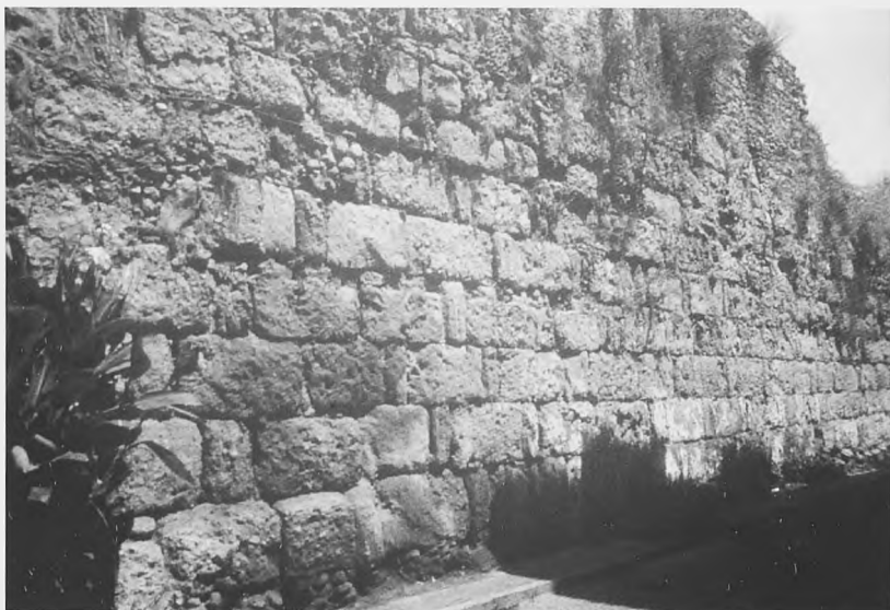
Fig. 7.- Aparejo a escaque de 1 tizón. Paredón sur de la alcazaba. (Marbella, Málaga)
