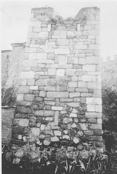
Fig. 22.- Vista frontal de torre arcáica con decoración en el esquema de sillares (Torre de los Deanes, Toledo).
