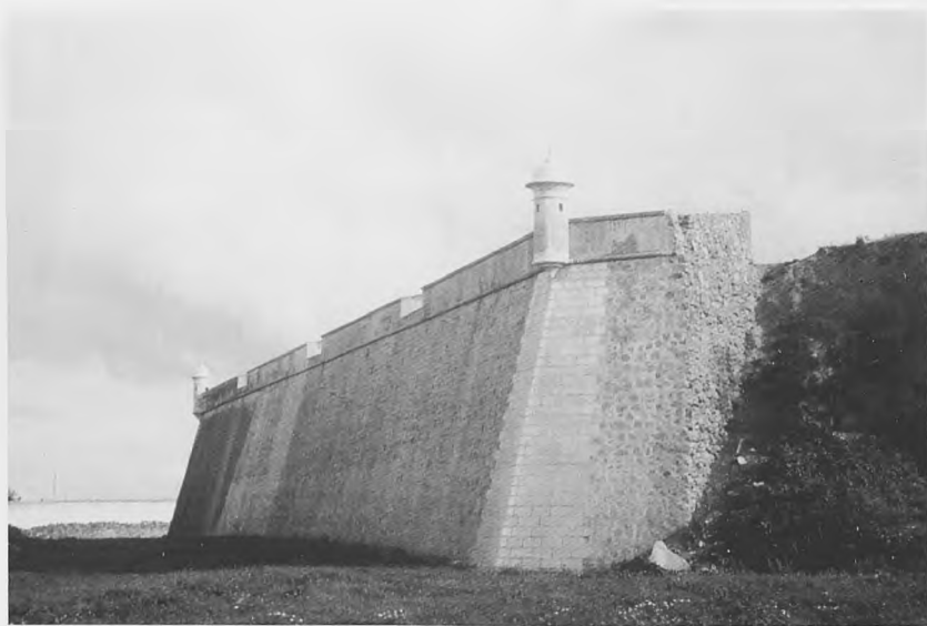
Fig. nº 9.- Restauración de un paramento donde se han incluido garitas de nueva construcción, perteneciente al recinto fortificado de Olivenza. (Ascensión Ferrer 1994).
