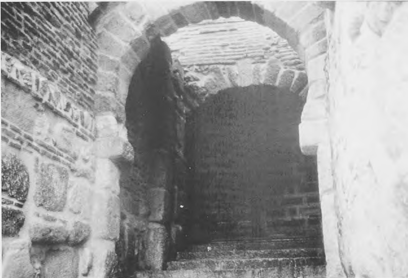
Fig. 13.- Arco de herradura con dovelas estrechas, no enjarjado. (Maqueda, Toledo)
