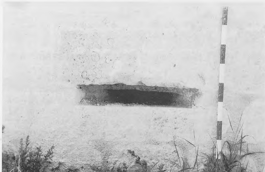
Fig. nº4: Torre Soto. Detalle de la tronera situada en el plinto.
