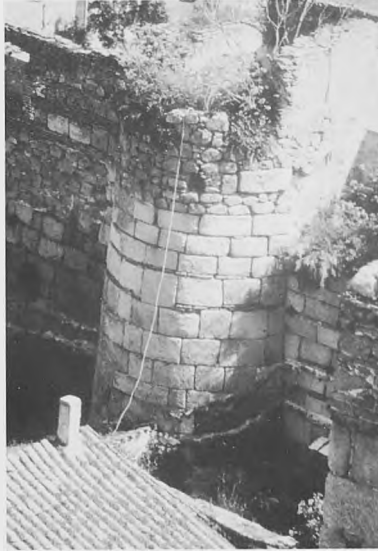
Fig. 20.- Ejemplo de torre con planta semicircular. (Talavera de la Reina, Toledo)
