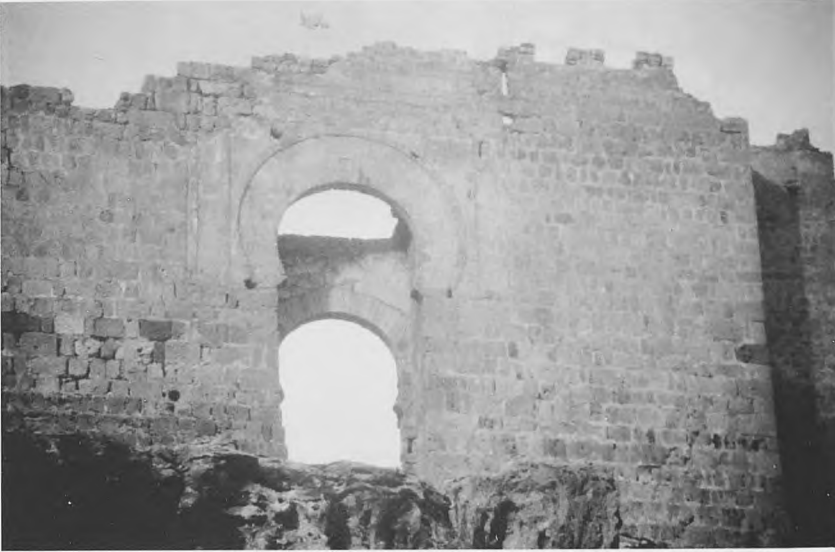
Fig. 24.- Puerta flanqueada por dos torres, saetera en piedra y rasgado de buhereda. (Gormaz B, Puerta "A", Soria).
