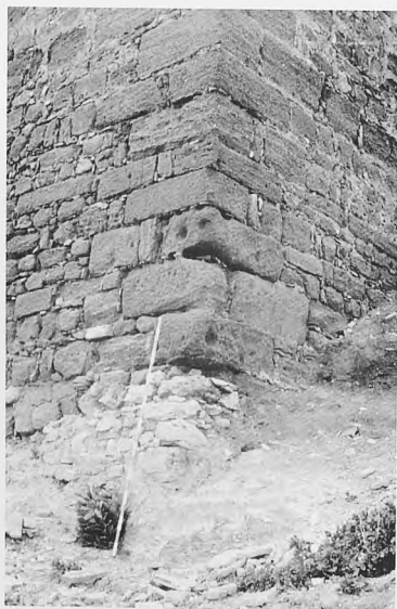
Foto 3.- Paramento de la torre occidental.
