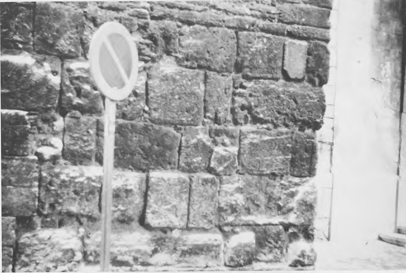
Fig. 8.- Sistema alterno de un tizón-dos tizones (Hª el 903. d.C.). (Castell Reial, Palma de Mallorca)
