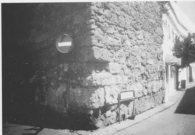
Fig. 42.- Vista de albarrana de planta cuadrada (Albarrana SW, Marbella, Málaga)
