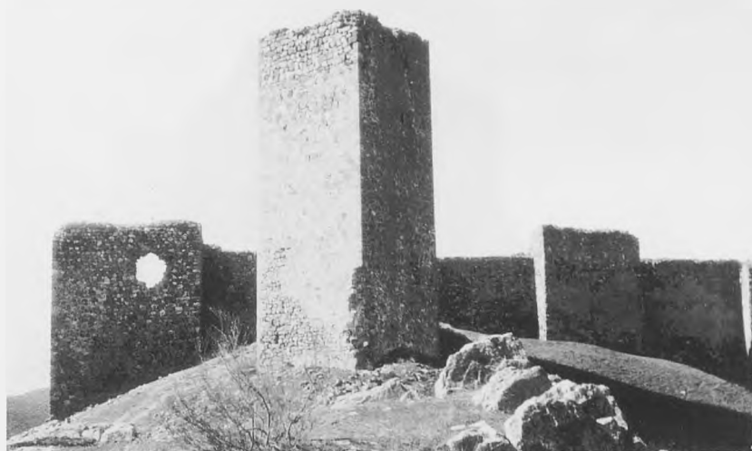
Foto 2.- Caracuel: Torre pentagonal albarrana y frente modificados por los cristianos en el s. XIII.
