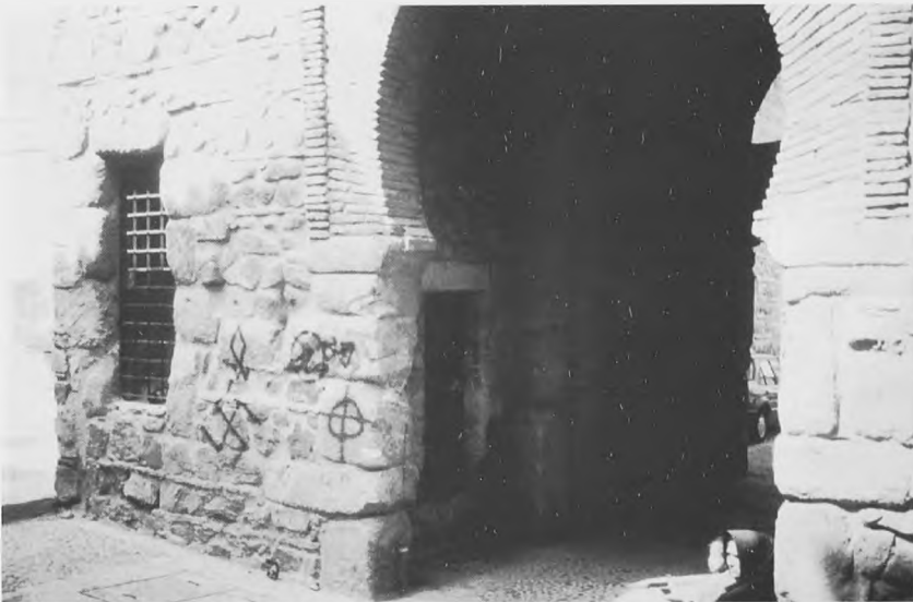
Fig. 29.- Recámara de puerta mostrando los accesos a las defensas verticales. (Puerta Vieja de Bisagra, Toledo).
