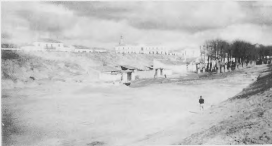
Fot. 4.- Vista del foso extramuros que discurría entre la Puerta de la Villa y el Cañuelo. El lateral sur del foso de la fortaleza no es otra cosa que la prolongación de esta arroyada.
