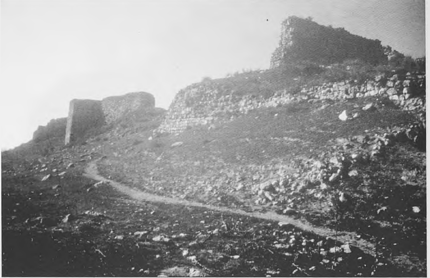
Fig. 18.- Vista de foso (Calatrava la Vieja, Ciudad Real)
