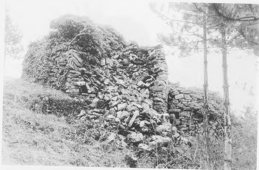
Foto 5.- Estructura del torreón 1: torre circular v estructura añadida
