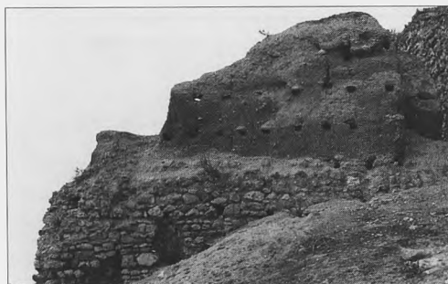
La torre albarrana ante la muralla sur de la ciudad de Calatrava la Vieja, tal como se conservaba en 1980, antes de las excavaciones
