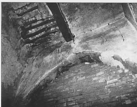
Lám. VIII.b: Arco diafragma de la crujía C y techumbre a base de vigas y «alcambias»
