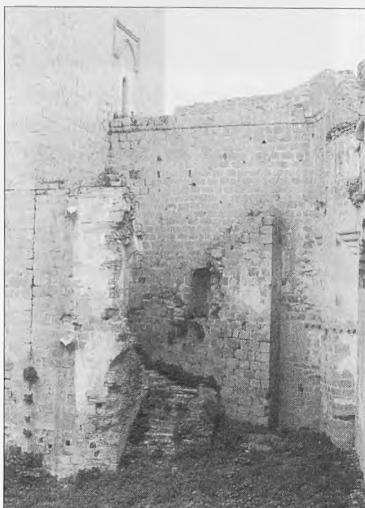
Lám.8 Detalle del monumental cuerpo de escaleras adosado a la torre del homenaje, que modifica el ingreso original de carácter defensivo
