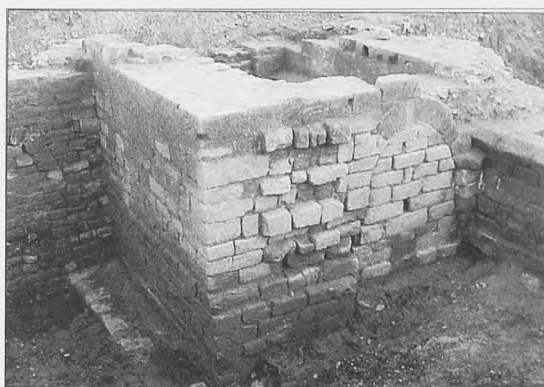
Foto 2. Vista exterior de los restos de la torre del castillo
