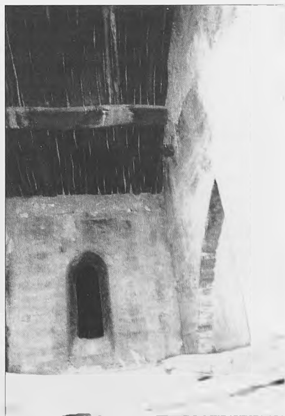
Lám. VI.b: Gran sala de la planta alta de la crujía A: ventana abierta en el muro 6 y a la derecha gran arco diafragma cegado; techumbre a dos aguas con «alcamias»
