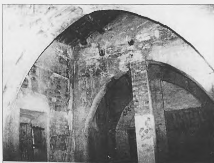
Lám. IV.b: Gran sala de la planta alta de la crujía A: grandes arcos apuntados de argamasa y techumbre a dos aguas. El arco central aparece apuntalado por un pilar moderno, mientras que el de más al fondo está tapiado
