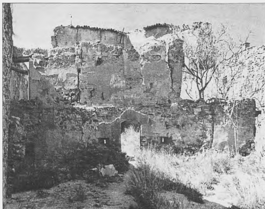
Lám. VII.b: Vista interna (desde el este) del muro conserva- do de la crujía oriental; en el centro, puerta en arco escarzano flanqueada por aspilleras
