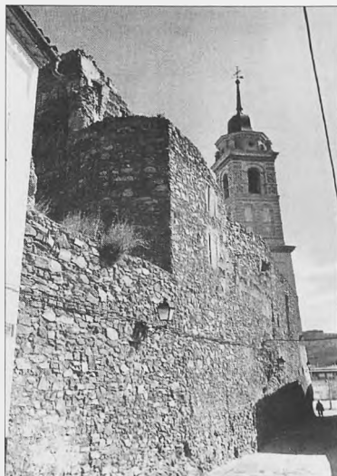
Lám. I.b: Vista del costado sur del fuerte y la torre del Reloj al fondo
