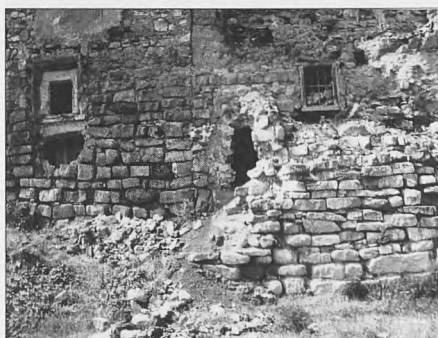
Lám. II.a: Muro 2 mostrando los dos paramentos superpuestos
