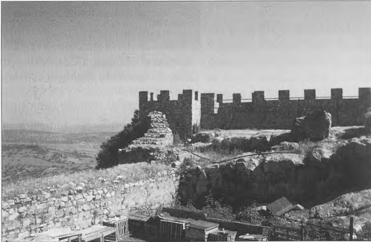
Lamina 2. Muro originario en el sector occidental del edificio. Al fondo torre y almenas recientemente reconstruidas
