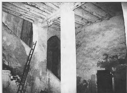
Lám. VI.a: Zaguán actual con escalera de subida a la planta alta
