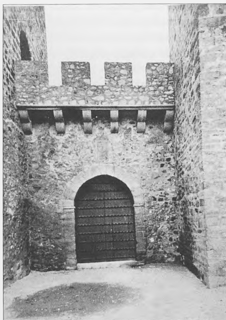
Fig. 2 - Castelo de Elvas. Porta da entrada depois da intervenção 1940-1948 (foto DGEMN)
