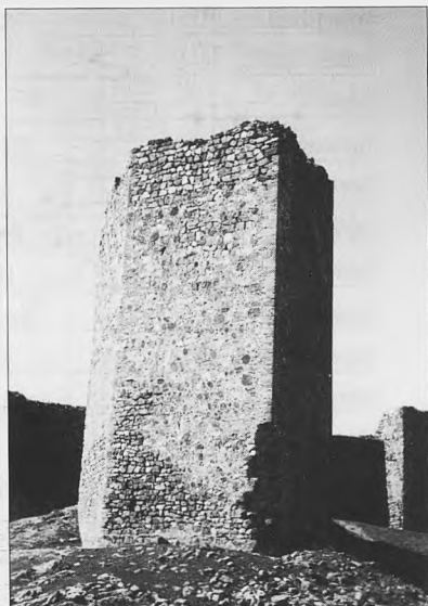
La gran torre pentagonal en proa, albarrana, de Caracuel (1980). Este yacimiento no ha sido excavado
