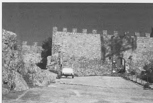
Lámina 6. Fachada actual del casti- llo de Chillón. La rampa de acceso ha destruido las primitivas estructuras que se extendían hacia el Este del edificio.
