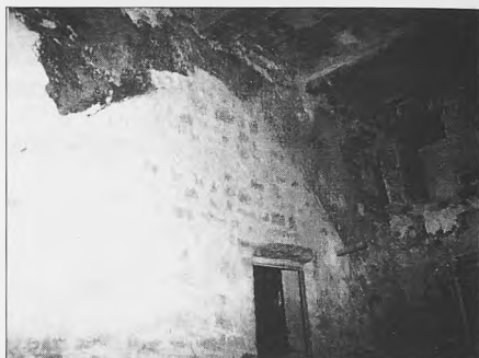
Lám. IV.a: El mismo arco visto del otro lado; a la derecha, ventana situada entre las crujías A y B
