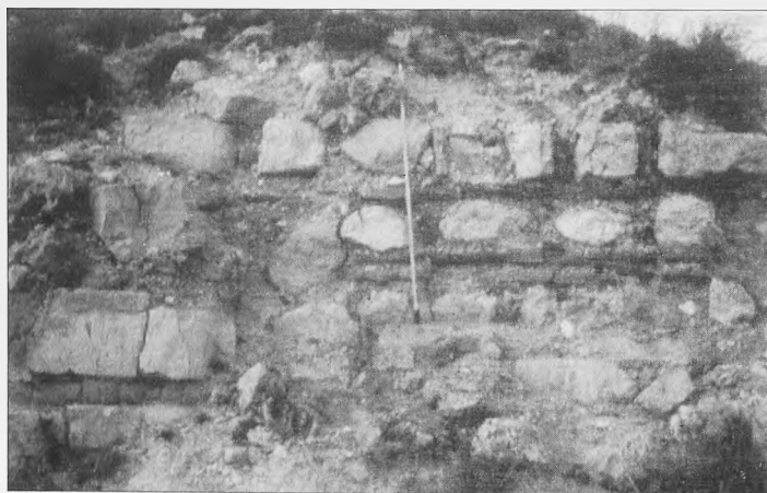
Paramento de mampostería encintada de tipo cajeadó
