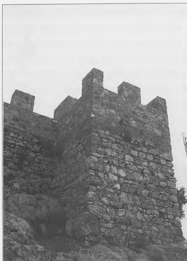
Lámina 3. Torre maciza en el flanco meridional. El tercio superior y las almenas son de reciente fábrica. Obsérvese la técnica constructiva a base de un enripiado de mampostería dispuesto en hiladas estrechas y que hemos datado en época emiral
