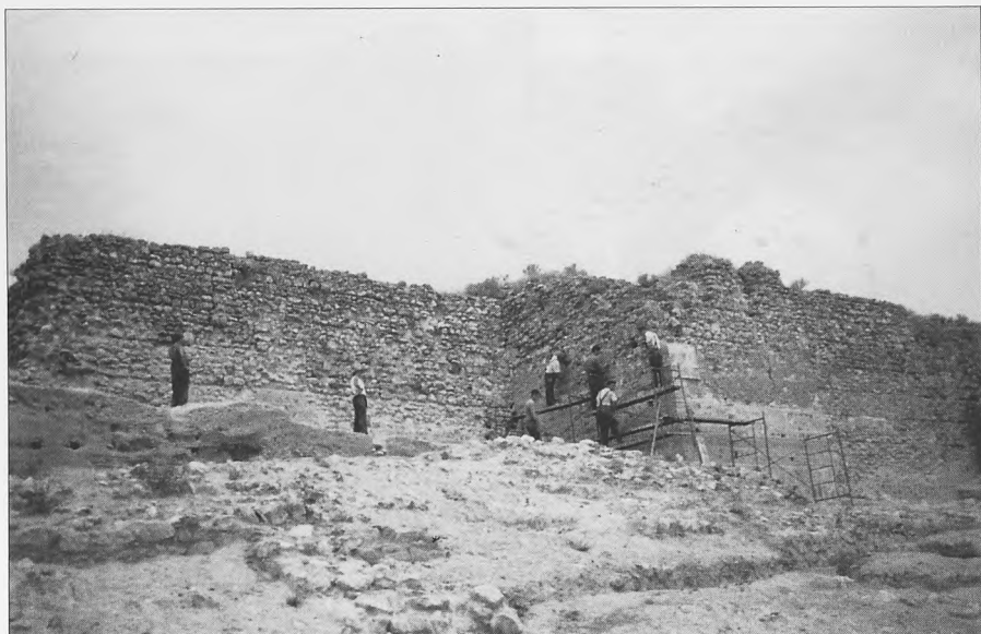
Excavaciones y restauración en la muralla de la ciudad (2003)
