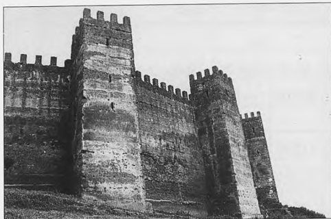
Muralla de Baños de la Encina, con la característica obra en Tabiya islámica, emiral-califa. Obsérvense las típicas torres rectangulares de escaso saliente con zarpas
