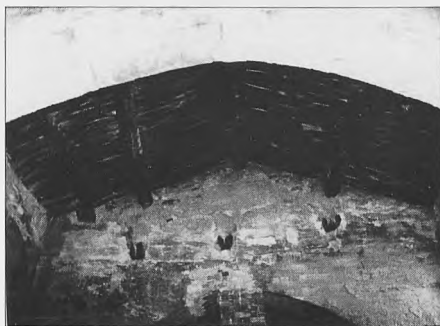
Lám. V.a: Detalle de la techumbre a dos aguas con «alcamias» de la gran sala de la planta alta de la crujía A
