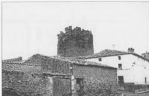
Foto 3b. Aspecto general de la torre antes de su restauración
