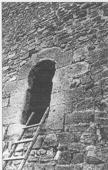
Foto 4a. Puerta de acceso. Vista desde el exterior
