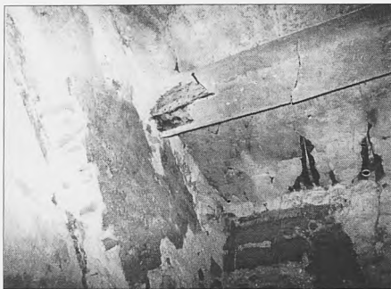
Lám. III.b: Detalle del arco diafragma anterior y de la techumbre mostrando jácena y «alcamias»
