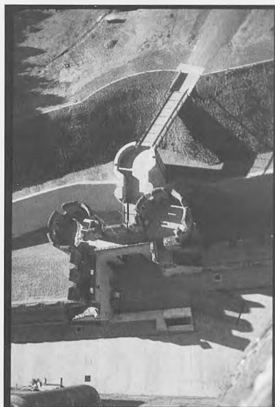
Castillo de la Mota. Torre del homenaje durante el rejuntado que respetó las huellas de los impactos del ataque del siglo XV y vista superior del baluarte de antepuerta después de la recuperación del recorrido original de acceso.
