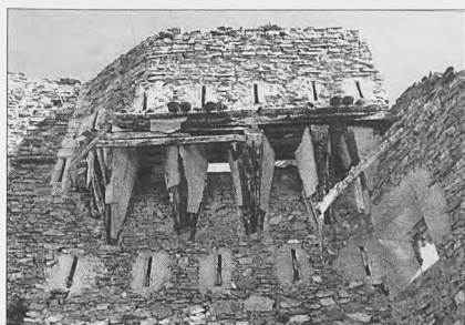
Lám. II.b: Ala sur de los matacanes del cuerpo oeste; debajo, aspilleras de la segunda planta y, a la derecha, tronera de la
