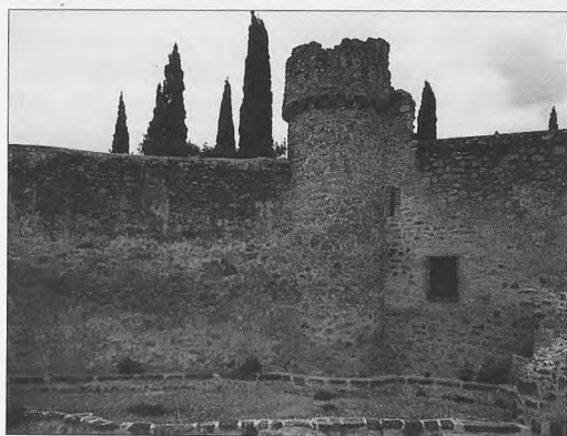
Convento principal de la Orden Militar de Trujillo
