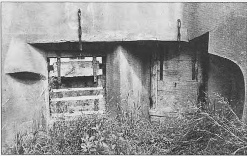
Lám. IV.b: Pareja de troneras (con sus cierres de mader- ra y cadenas de sujeción) en la segunda plan- ta de la torre norte
