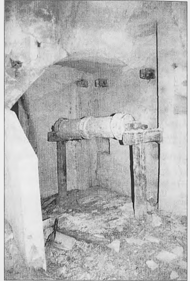
Lám. IV.a: Torno de madera en la planta segunda del cuerpo oeste; arran- que de la escalera
