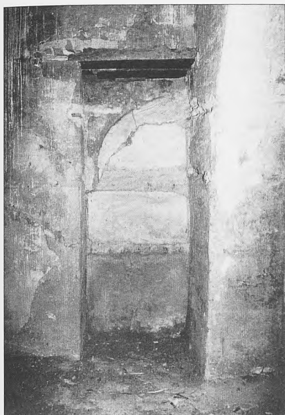
Lám. V.b: Puerta original cegada en el muro 6 de la gran sala de la planta alta de la crujía A
