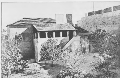
Fig. 4 - Castelo de Elvas. Alcaidaria depois da intervenção de 1940-1948 (foto DGEMN)
