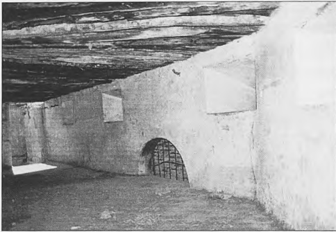
Lám. III.b: Interior de la planta primera del cuerpo oeste: aspilleras, colgadores y rastrillo
