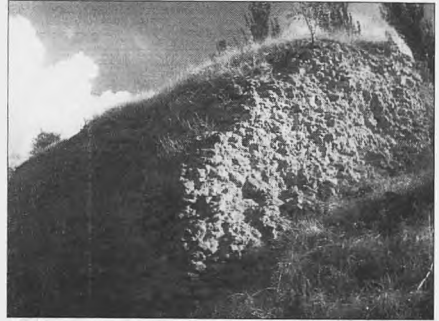
Detalle de la unión del muro del castillo con la barrera artillera
