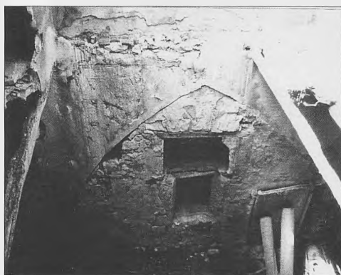
Lám. VIII.a: Vista del patio central, con los dos voladizos y uno de los arcos de la planta baja de la crujía B, hoy cegado
