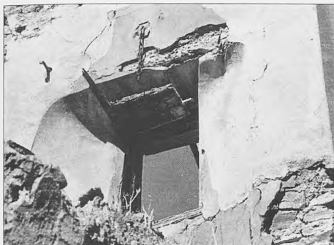
Lám. V.a: Vista interior de la tronera de madera de la torre sur mostrando el mandilete de made- ra
