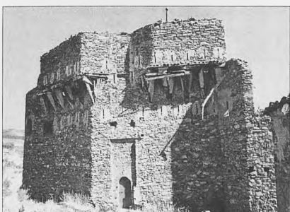
Lám. II.a: Recinto interior del fuerte: vista exterior del cuerpo oeste con el ingreso y el voladizo amatacanado
