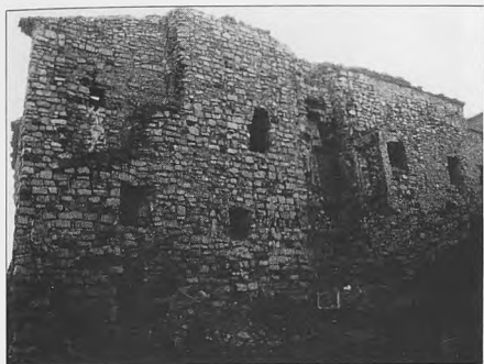
Lám. I.b: Fachada noroeste (muro 1), con restos de la torre semicircular
