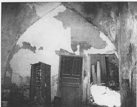
Lám. VII.b: Arco diafragma cegado de la planta baja de la crujía B, visto desde el zaguán
