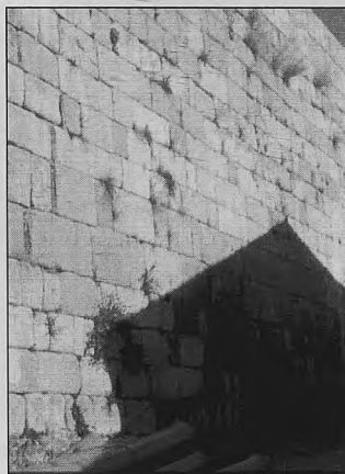
Foto 111. Cáceres, Coria, detalle de la muralla
