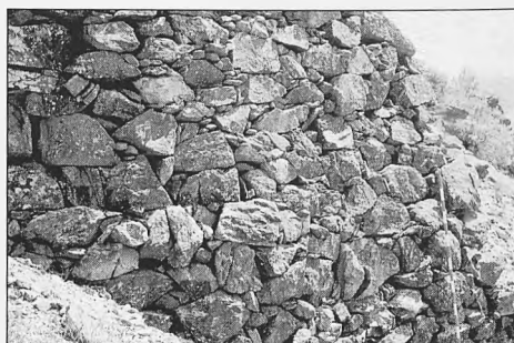
Fig. 6 Detalle de la fábrica del lienzo de muralla
