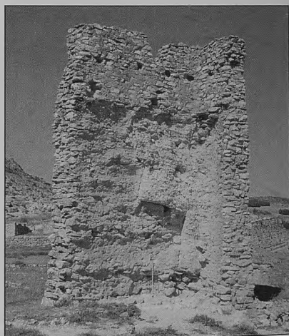
Figura 25 Castillo de Godojos: vista interna de la zona superior de la esquina noreste del recinto externo; arriba, vigas embutidas en la fábrica de mampostería o tapias de cal
