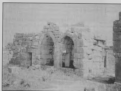
Foto 60. Mustis, cámaras junto entrada
