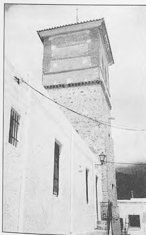
Foto 3. Iglesia de Enix. Fachada lateral derecha y torre
