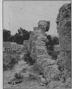
Foto 88. Henchir Fraga, frente este exterior
