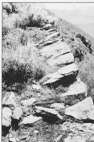
Fig. 12 Murete de contención del borde exterior del camino de acceso a la cantera de Peña Mayor
