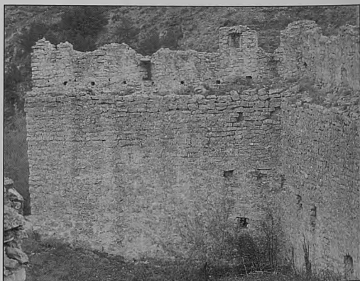
Figura 32 Castillo de Bijuesca: vista interior de uno de los muros del recinto superior (mampostería de cal), en que se observa el parapeto almenado en cuya base aparecen los mechinales para las vigas del dispositivo líneo
