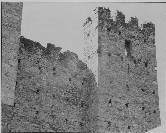
Figura 30 Castillo de Ruesta: exterior de la torre menor con cadalso de doble hilera de mechinales y puerta de salida a la galería; a la izquierda, arranque del lienzo con posible cadalso
