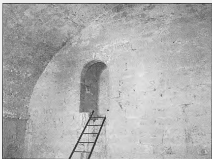
Estancia abovedada en el interior de la torre
