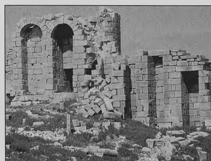
Foto 17. Haidra, frente este, interno zona centro
