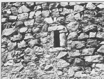
Torre La Higuera, ventana en frente este
