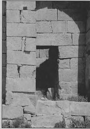
Foto 22. Haidra, frente este, puerta torre central redonda
