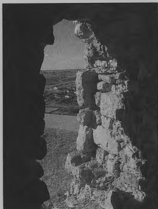
Lamina 4: Vista desde la puerta de la Torre del pueblo de La Torresaviñán. En primer plano apoyos de la puerta de entrada, y piedras de sillería.
