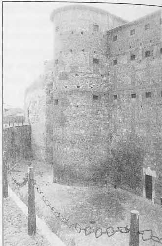
Fachada principal, realizada en el siglo XIX
