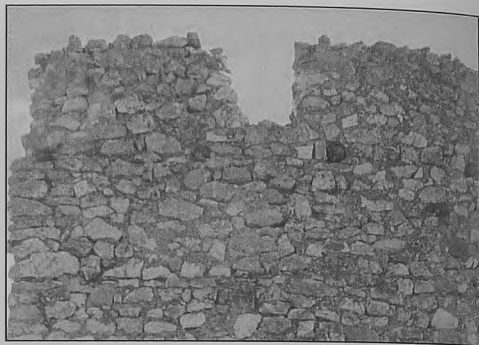
Figura 23 Castillo de Godojos: vista externa de la zona superior del muro norte de la esquina noreste del recinto exterior con vigas para suelo del cadalso, parapeto y posible vano de acceso
