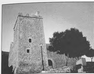
Foto 9 Iglesia de Vicar. Fachada lateral izquierda y torre
