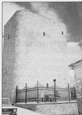
La torre restaurada
