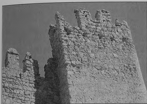
Figura 13 Castillo de Arándiga: costado oeste de la torre sur (mampostería de cal) mostrando los mechinales para cadalso y, en el extremo izquierdo, la puerta de acceso a la galería
