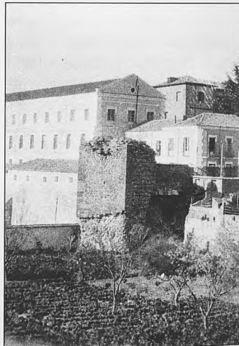
Fig. 6 Puerta de Alvar Fáñez, el baluarte en estado de ruina. Fotografía anónima, c. 1920
