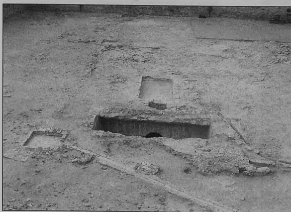
Sistema de captación y almacenamiento de agua
