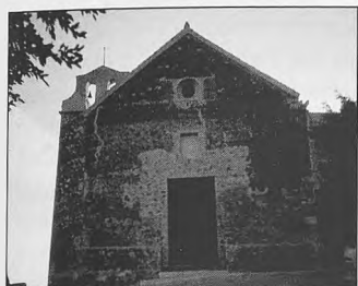
Foto 10 Iglesia de Vicar. Fachada principal
