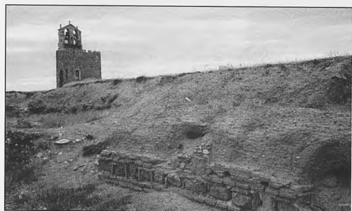
Recinto del castillo. Mampostería encintada y muro de tapial. Al fondo «La Martina»
