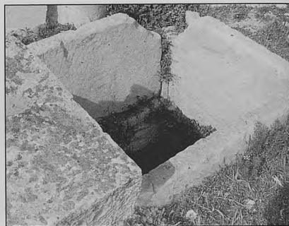
Foto 98. Haidra, arco-fortaleza, cisterna
