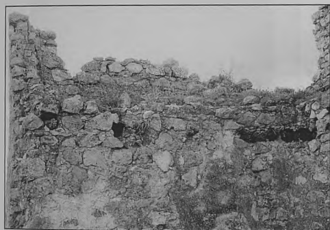
Figura 15 Castillo de Arándiga: zona alta del costado oriental de la torre sur al interior; se observa el parapeto almenado y el adarve, bajo el que asoman las vigas del suelo del cadalso, concentradas en gran número en el ángulo interno
