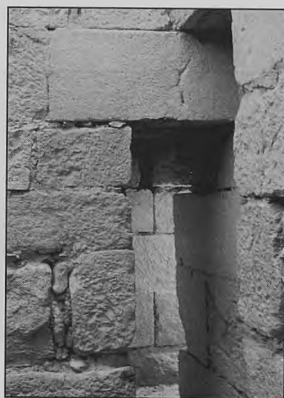
Foto 84. Ksar Lamsa, torre suroeste entrada planta baja
