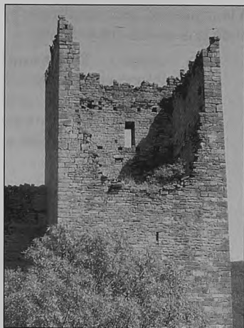
Figura 31 Castillo de Ruesta: interior de la torre grande mostrando la doble hilera de mechinales para cadalso corrido y el vano de acceso a éste
