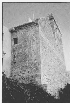
Foto 3. Iglesia de Enix. Fachada lateral derecha y torre
