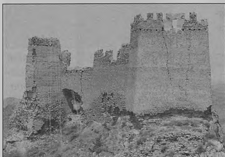
Figura 10 Castillo de Arándiga: vista general desde el sur. A la izquierda, torre oeste; a la derecha, torre sur. Entre ambas, muro 2 (con puerta) y muro 1 (con hueco para buharda ligera a mitad)
