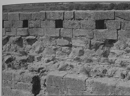
Figura 5 Castillo de Sádaba: adarve y parapeto del lienzo oeste desde el interior, mostrando los mechinales para cadalso
