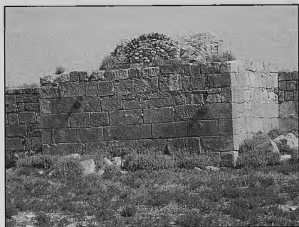
Foto 25. Haidra, frente norte, torre central
