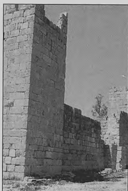
Foto 81. Ksar Lamsa, frente entrada
