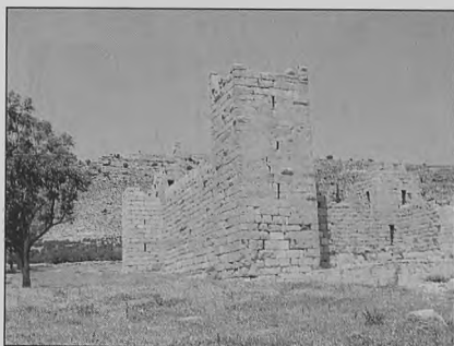
Foto 82. Ksar Lamsa, torre sureste
