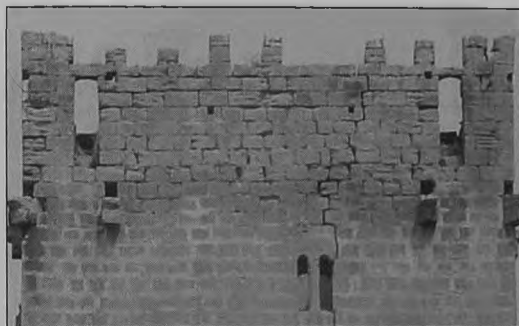
Figura 26 Castillo de Yéquera: cara sur de la torre principal mostrando los mechinales para las vigas de las buhardas de esquina, así como las ménsulas de apoyo y los vanos de salida
