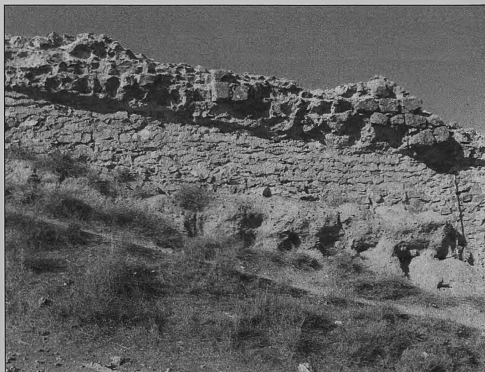
Lám. 6 Forro de mampostería y restos del derrumbre de los tapias en la zona norte del albacar
