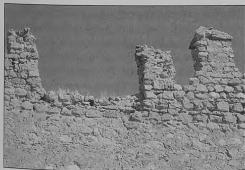
Figura 16 Castillo de Arándiga: hueco del parapeto del muro 1 donde se insertaba la buharda de madera de la que permanecen las tres vigas de su base
