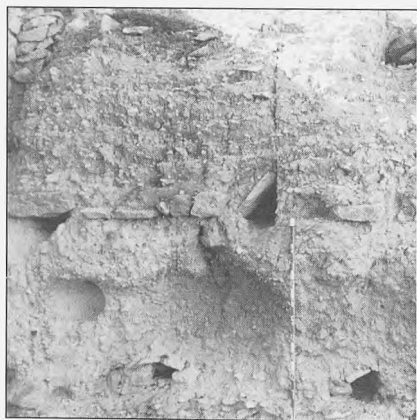
Detalle de la tapia de tierra apisonada en el lado occidental del conjunto
