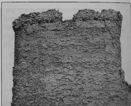
Figura 18 Castillo de Arándiga: cara oeste de la torre norte (tapias de yeso) mostrando la hilera de vigas del cadalso y la puerta de acceso a éste
