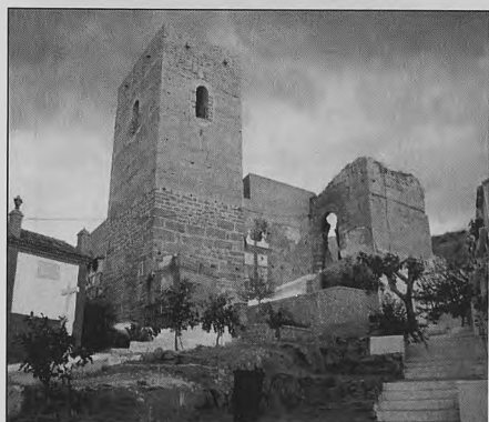
Foto 116. Málaga, Álora, sillares base torre
