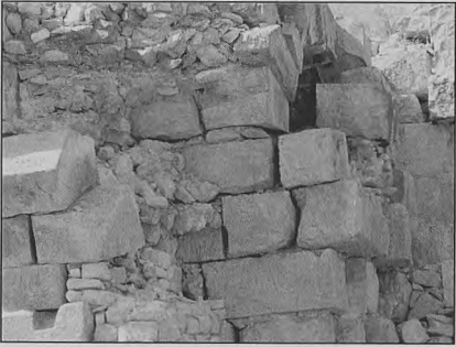
Foto 21. Haidra, frente este, comp. muro detalle
