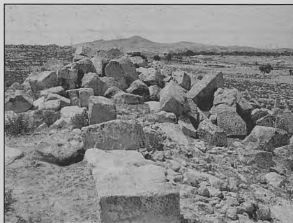
Foto 4. Thelepta, torre centra, frente oeste
