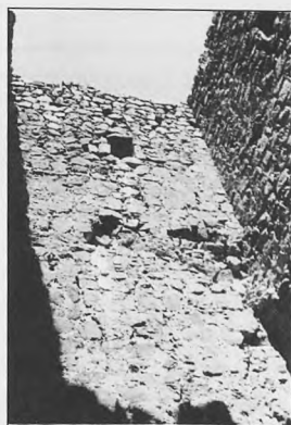
Frente este interno con restos de la bóveda, ventana y mechinales
