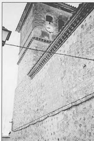
Foto 4 Iglesia de Enix. Fachada posterior y torre
