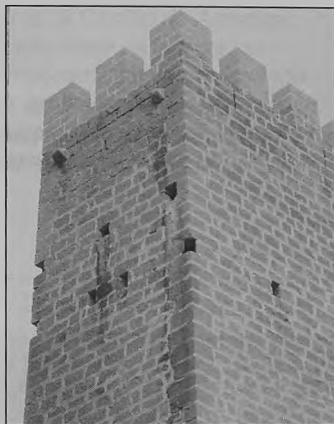
Figura 6 Castillo de Sádaba: cara oeste de la torre sur mostrando doble hilera de mechinales, la inferior para cadalso y la superior para adarve volado, así como las ménsulas de apoyo del techo de este último. La diferencia de altura de apenas un metro entre ambos dispositivos impide su utilización simultánea
