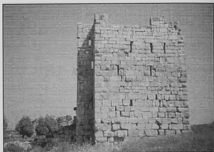
Foto 74. Ain Tounga, torre sureste y frente sur
