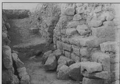
Foto 126. Cáceres, Trujillo entrada recta a la alcazaba
