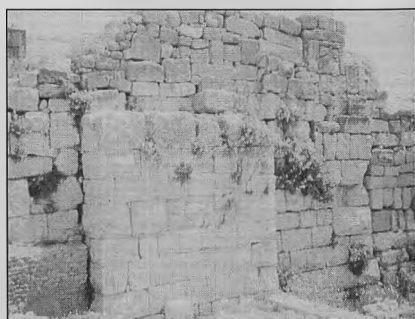
Foto 54. Dugga, torre frente oeste
