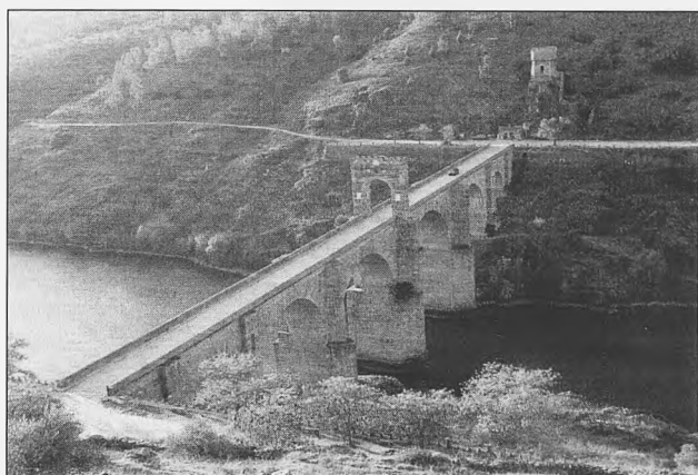
Fig. 2. Puente romano de Alcántara
