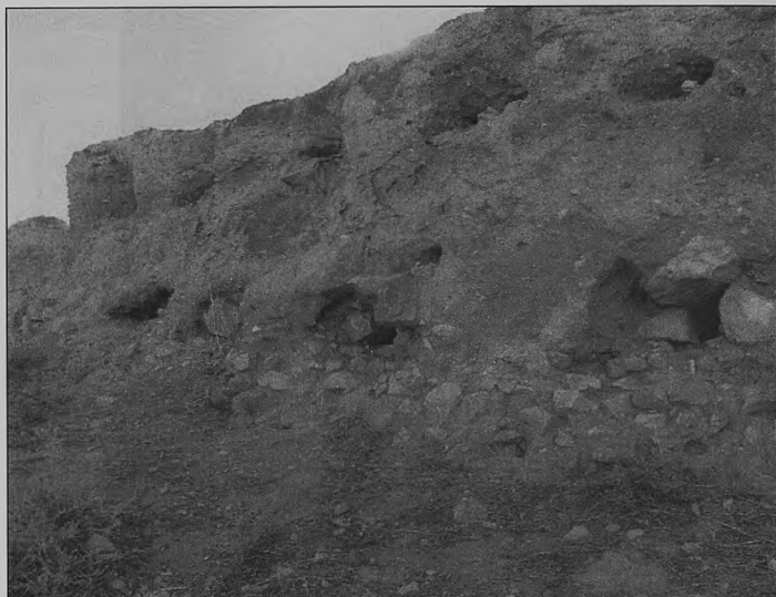
Lám. 5 Detalle del alzado del muro tapial
