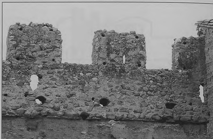
Figura 35 Murallas de Villaroya de la Sierra: vista externa del parapeto almenado de uno de los lienzos, mostrando visibles mechinales circulares de finalidad desconocida
