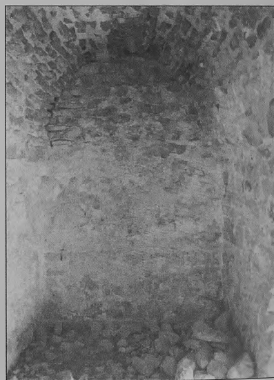
Lamina 7: Vista del interior de la planta sótano, se puede ver el sistema constructivo empleado, y la bóveda de medio cañón, así como el revoque en cal
