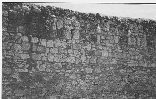
Muralla de la villa de Ayllón. Calle Adarves. Muralla recrecida y almenas tapiadas
