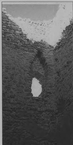
Lamina 5: Vista desde el interior de la Torre del vano de la tercera planta, arco apuntado conseguido a través de aproximación de hiladas.
