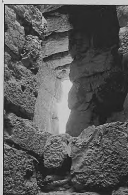
Foto 83. Ksar Lamsa, torre sureste entrada 2º piso
