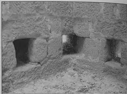
Figura 9 Castillo de Sádaba: interior de los mechinales para cadalso en una de las torres
