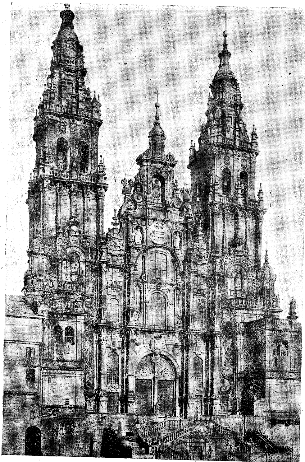
Fachada principal de la Catedral de Santiago, obra barroca de Casas Novoa (1738)
