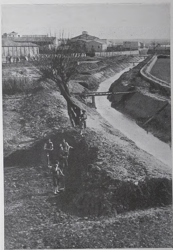
Obras de encauzamiento del Sió, aguas abajo del puente romano.
