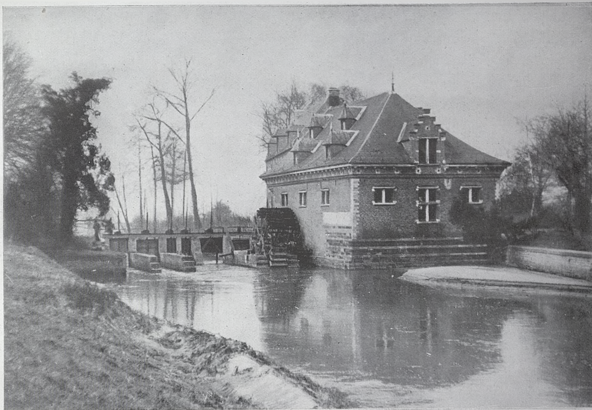
Castillo de Arenberg. Pabellón adjunto.
