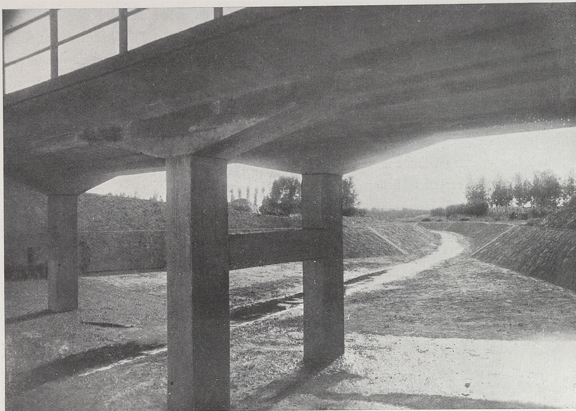
Encauzamiento del río Sió.
