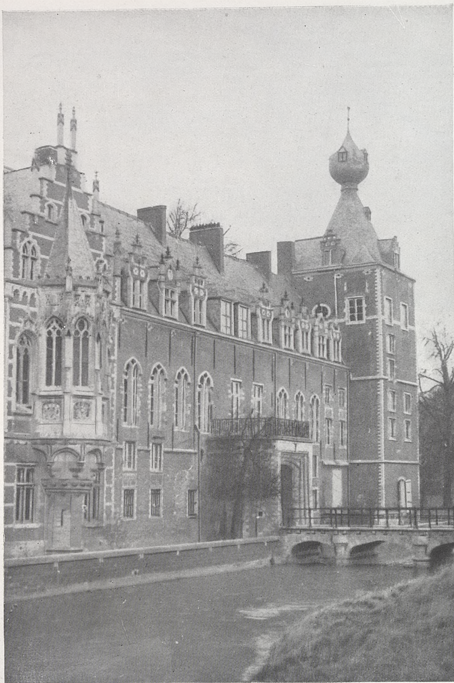
El castillo de Arenberg. Fachada principal.
