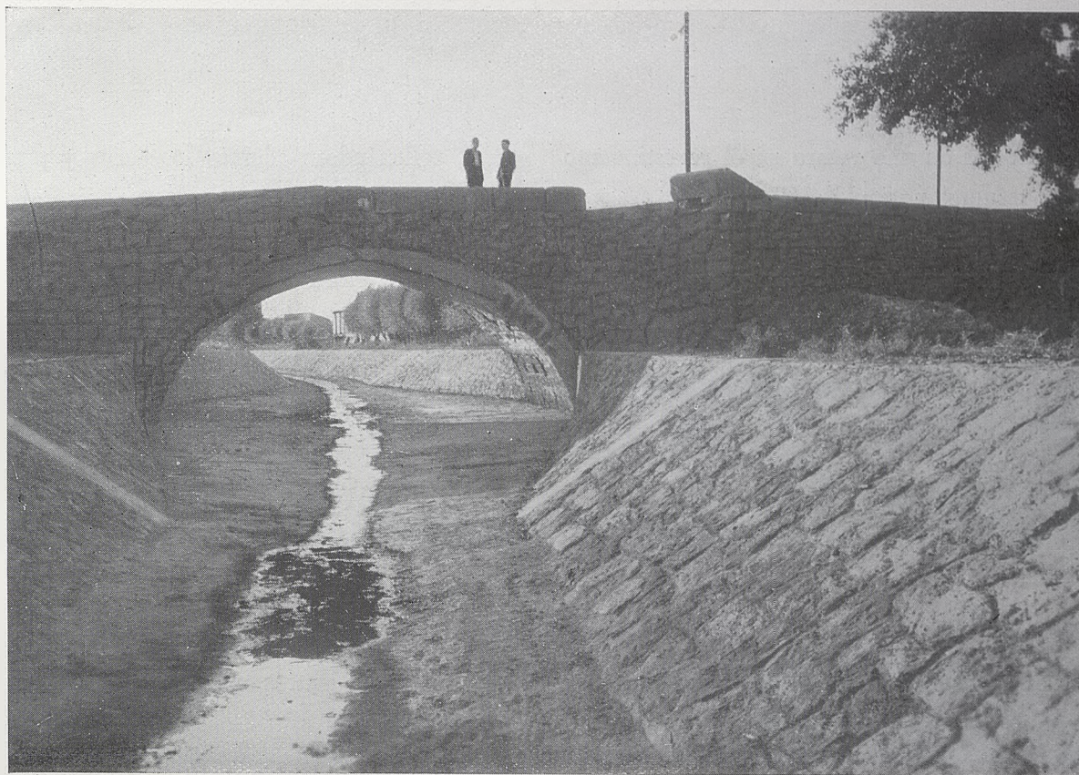
Obras de encauzamiento.
