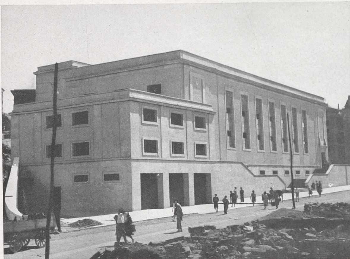
EIBAR.—Mercado. Fachada principal.
