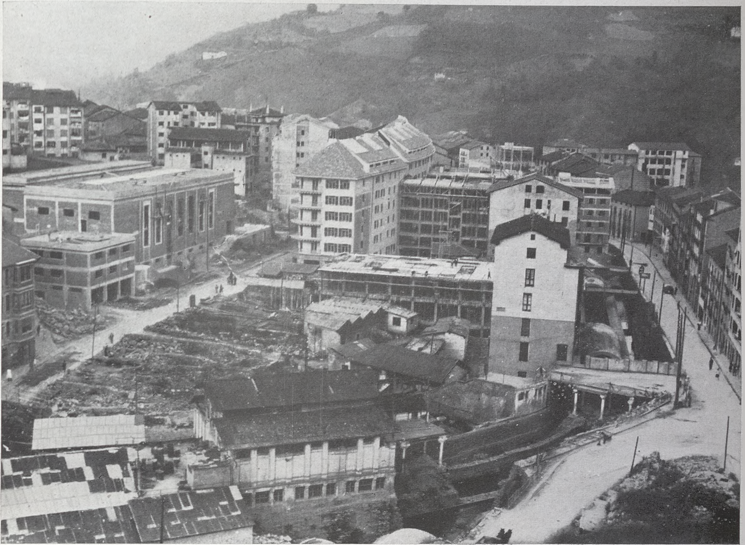
EIBAR.—Obras de reconstrucción. En el centro, bloque de viviendas de nueva planta. A la izquierda, el mercado.
