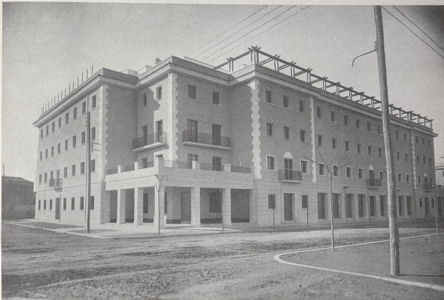
Vista general del bloque.
