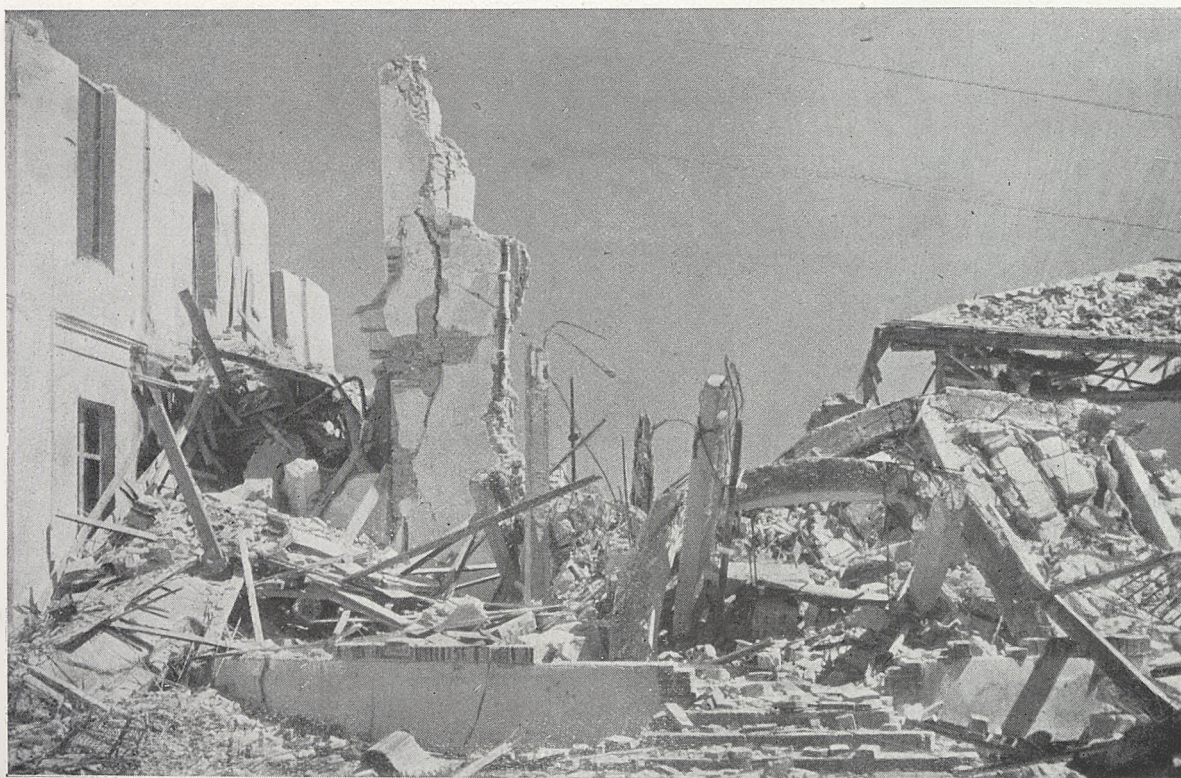
Destrucciones en el barrio de San Severiano.
