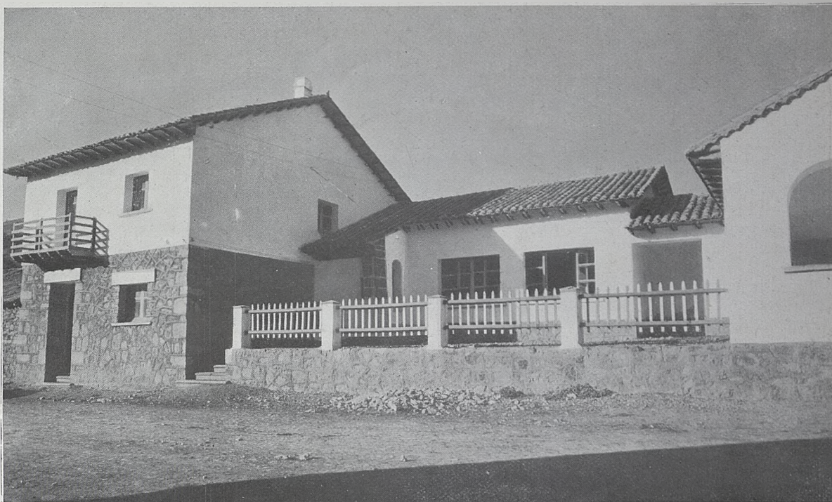
Villamanin (León).—Escuela y viviendas para maestros.
