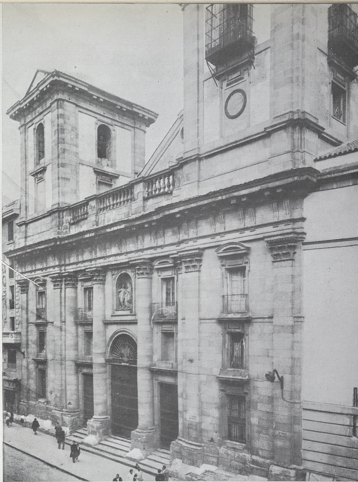
Fachada principal, restaurada.
