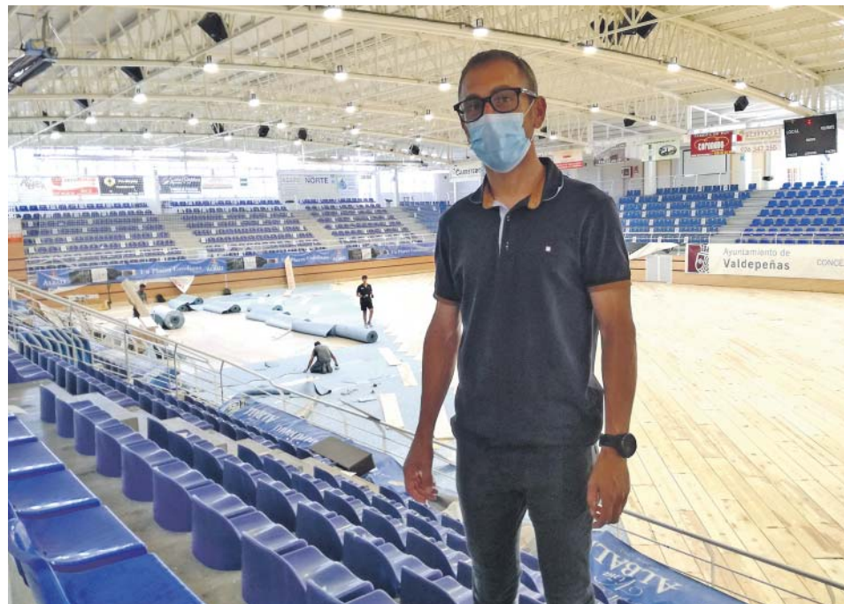
EL CONCEJAL DE DEPORTES VIENDO LA INSTALACIÓN DE LA NUEVA PISTA /M.G.
