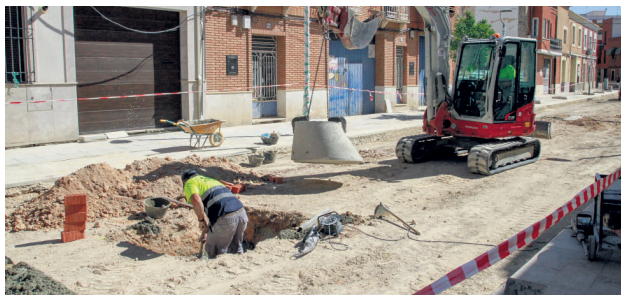
CABALLERO VISITA LAS OBRAS DE LA CALLE TORRECILLA
