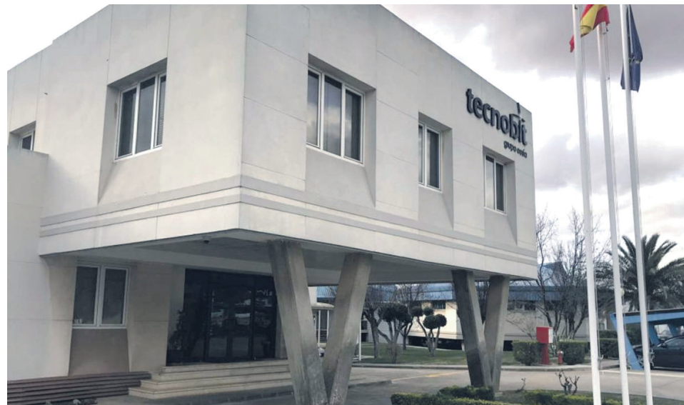
INSTALACIONES DE TECNOBIT-GRUPO OESÍA EN VALDEPEÑAS / LANZA
