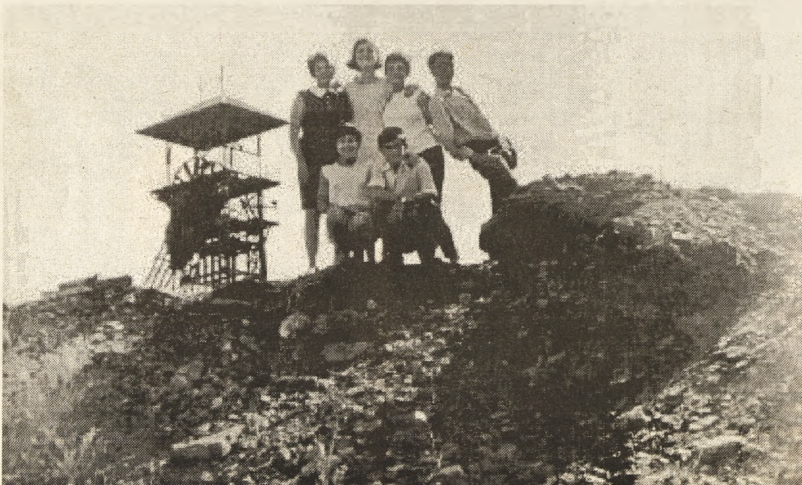
Escombreras de la «Minilla» al fondo castillete del Pozo Norte
