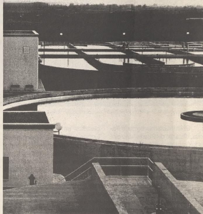
una zona catalogada como sensible, dispondrán de fase de pretratamiento y de una etapa primaria por decantación; a continuación, en Carrión y en Torralba se aplicará un tratamiento biológico del tipo biomasa, mientras que en Fernancaballero se utilizará uno anaeróbico en canales de oxidación. Los procesos finales serán la eliminación del fósforo y la decantación secundaria.
