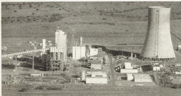
**ELCOGAS HA CONSTRUIDO EN PUERTOLLANO, LA MAYOR CENTRAL ELECTRICA DEL MUNDO DE GASIFICACION INTEGRADA EN CICLO COMBINADO (GICC), QUE DESARROLLA UN AVANZADO PROCESO DESTINADO A LA UTILIZACION LIMPIA DE LOS CARBONES DE LA COMARCA.**
