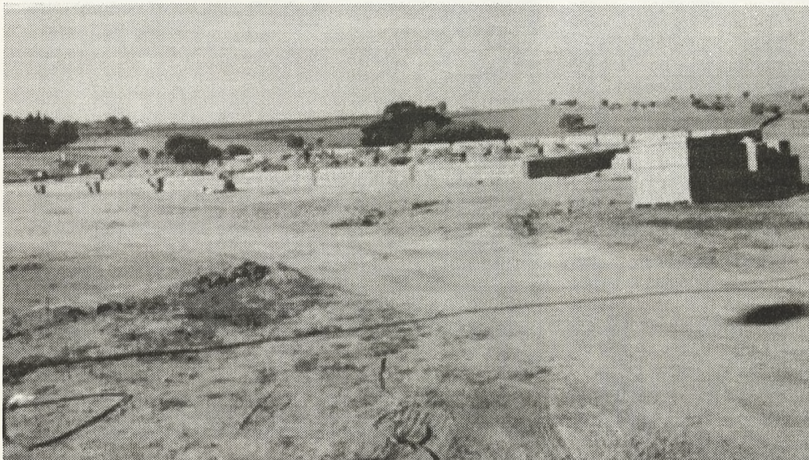
Estado de las obras del Centro de Iniciativas
