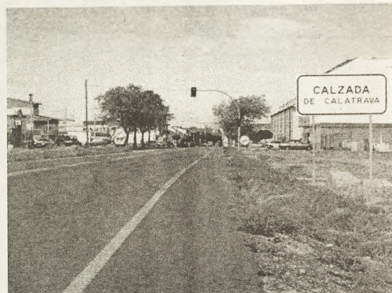
Acondicionamiento de los accesos a la localidad
