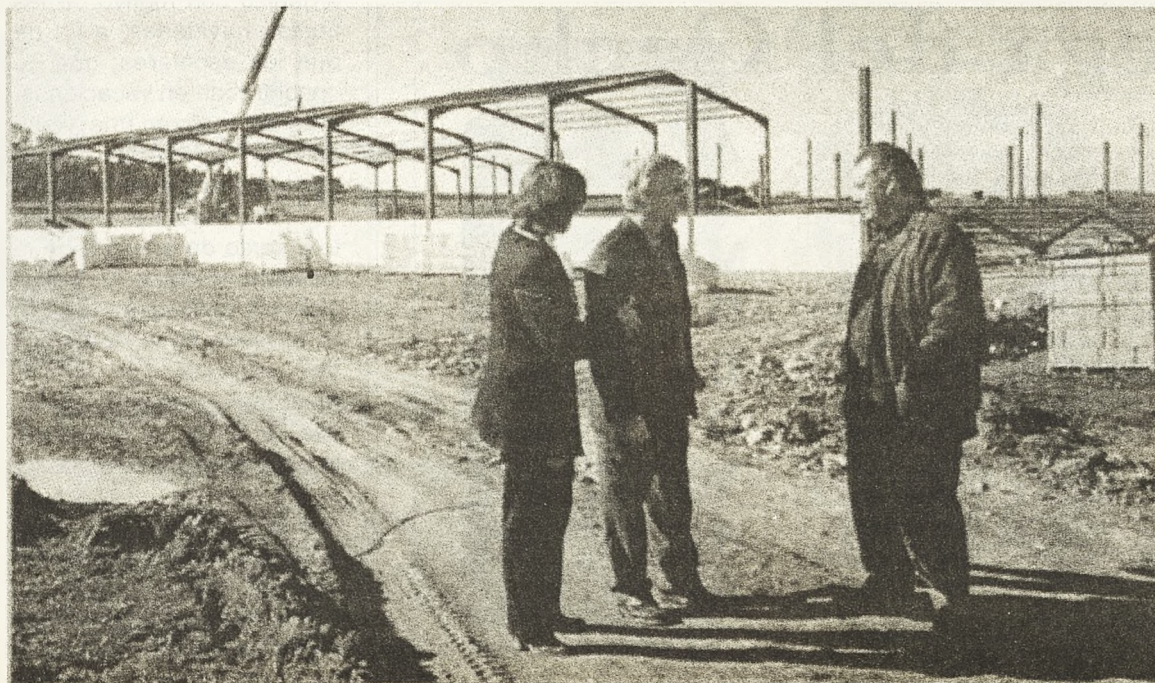
En compañía de Luis Mansilla, supervisó de cerca el estado de las obras de ampliación de la Escuela Universitaria
