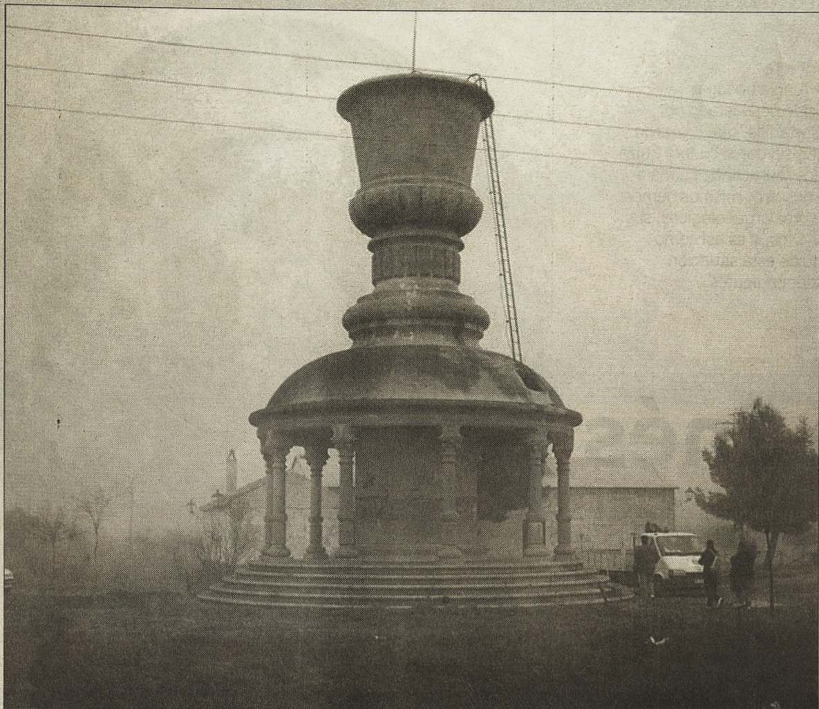
► «La Copa», antiguo depósito de suministro de agua para la población de Herencia
