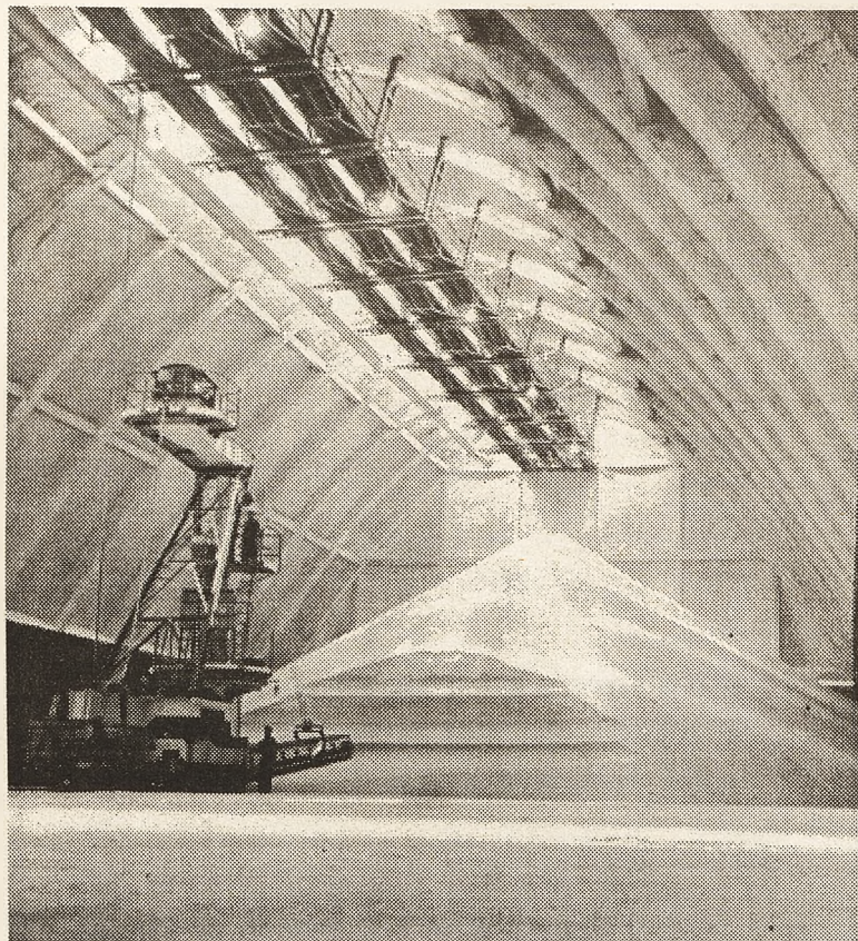
Interior del silo de nitrato
