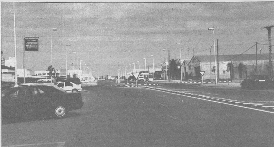
Las infraestructuras de Villarrobledo han sufrido en estos últimos años una mejora cualitativa y cuantitativa, puesto que las rondas de circunvalación realizadas hacen posible que no se tengan que atravesar el centro de la localidad, con el consiguiente peligro que se evita.
