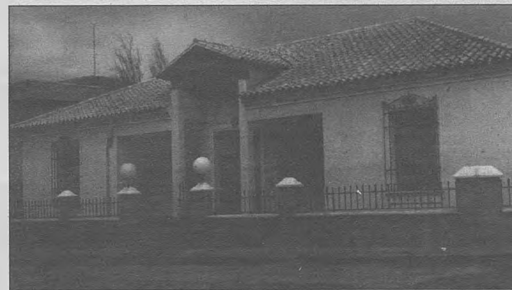
En la fotografía superior el Ayuntamiento, recientemente reformado. Más abajo el Polideportivo cubierto y el Centro Social que, junto a la Casa de Cultura-Auditorio y el Centro de Salud conforman lo más importante de los nuevos servicios con lo que se ha dotado al pueblo
