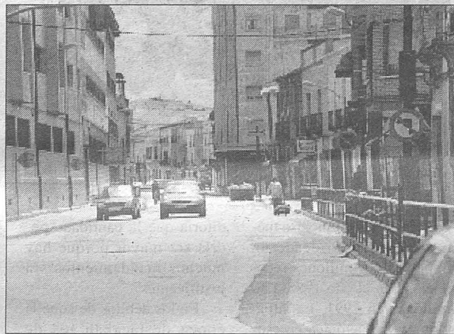
Dos vistas de las edificaciones que se comentan. Arriba un primer plano de una obra realizada en la calle Socuéllamos vista desde la Plaza de España. Sobre estas líneas, en la fotografía se muestra la alineación que tomarán las edificaciones con el edificio de Unicaja.
