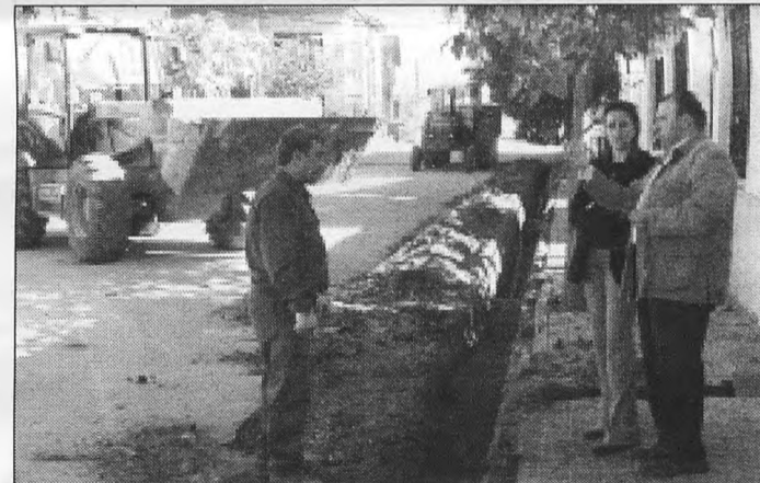
El alcalde de Pedro Muñoz, Ángel Exojo, visitó las obras que se desarrollan en la calle Carlos Garzarán, en el tramo comprendido entre Doctor Fernando Mayordomo y Maestro Juan de Ávila.
