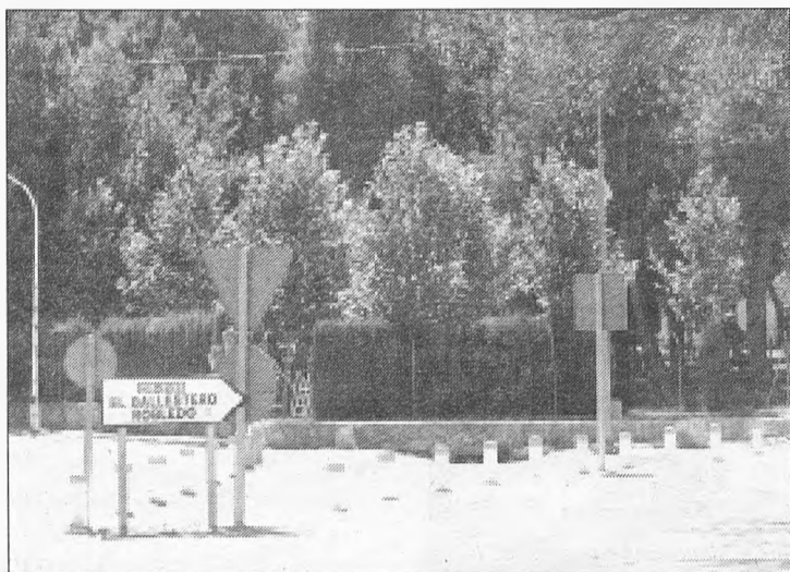
Una de las actuaciones que va a ejecutar la Consejería de Obras Públicas tendrá como objetivo la mejora del drenaje de la travesía de la carretera CM-3133, a su paso por la localidad de El Bonillo.
