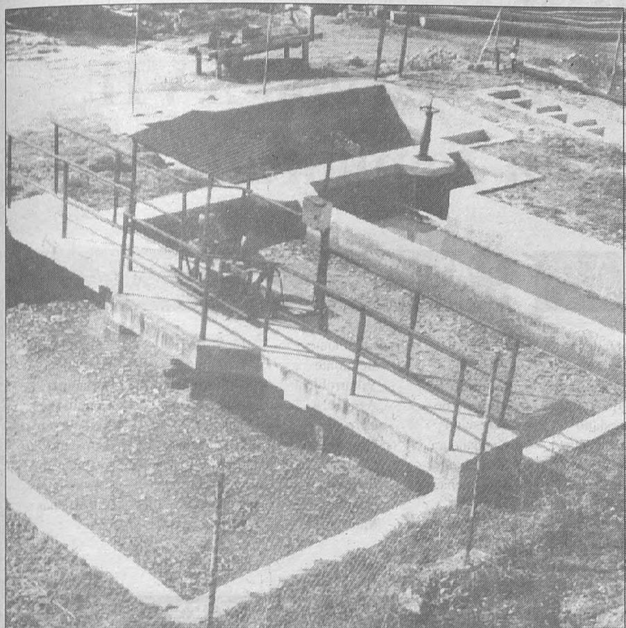
Depuración de aguas residuales.
