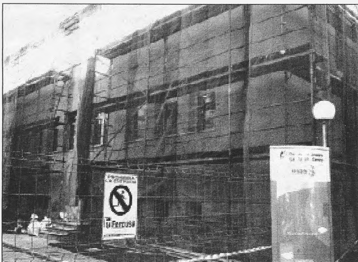
Imagen de las obras de ampliación del Hospital Virgen de Altagracia, en la que el SESCOAM invertirá cerca de 6,5 millones de euros, y que deberán estar terminadas en julio de 2007.
