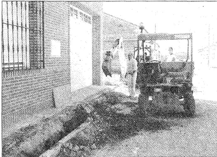
Una vez terminada la colocación de esta tubería, se procederá al reposicionamiento de las acometidas domiciliarias, el acerao y los pavimentos de la calzada afectados, estimándose el plazo de ejecución de este proyecto en unos tres meses.
