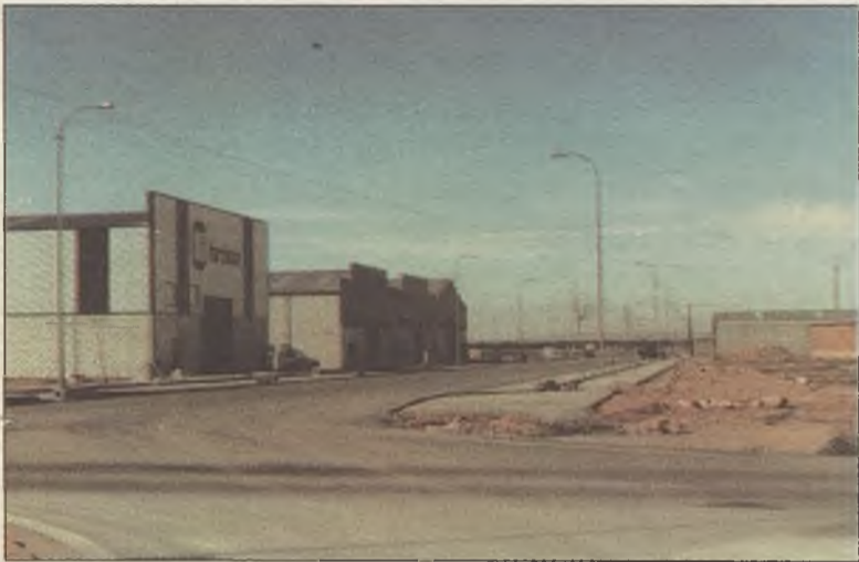
Vista de SERYCAL, un día después de procederse al asfaltado de su avenida principal en cuyo momento ya se habían adquirido el 20 por ciento de sus parcelas
