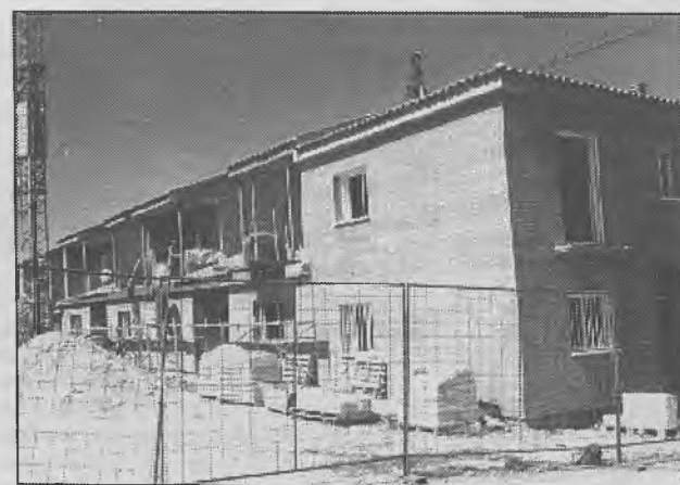
Foto de archivo de las viviendas durante su construcción.
