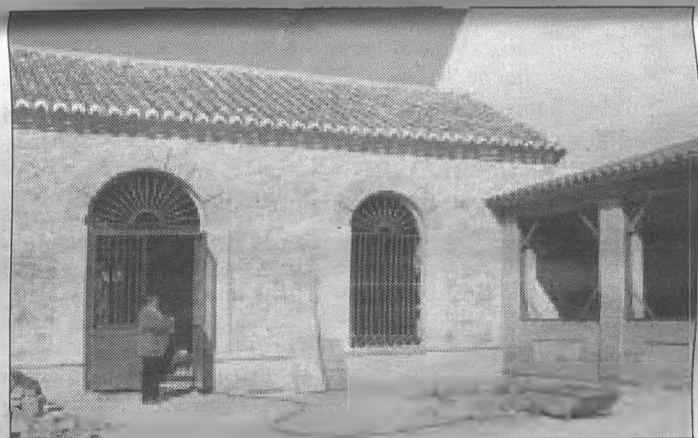
Estado actual de las obras del patio central del Museo Etnográfico y Agrícola de Villarrubia de los Ojos.
