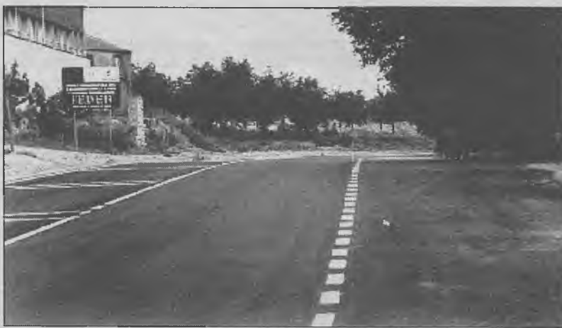
Ya ha entrado en servicio el tramo de 4,870 Kms. de la CM-3103 perteneciente a la provincia de Ciudad Real, desde Pedro Muñoz hasta el término de la provincia de Toledo. Las obras han sido realizadas por la Consejería de Obras Públicas y han supuesto una inversión de 57 millones.
