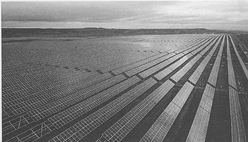
Planta fotovoltaica Carpio De Tajo en Toledo
