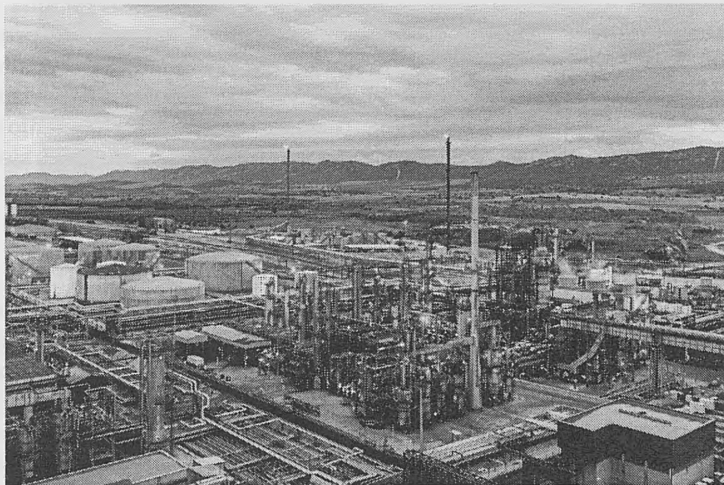
Complejo Repsol en Puertollano
