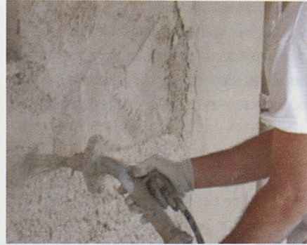
Revoque proyectado a maquina
