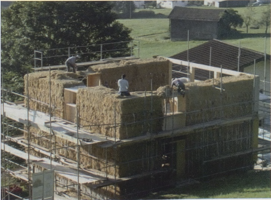
Construcción de vivienda con la paja como elemento portante.
