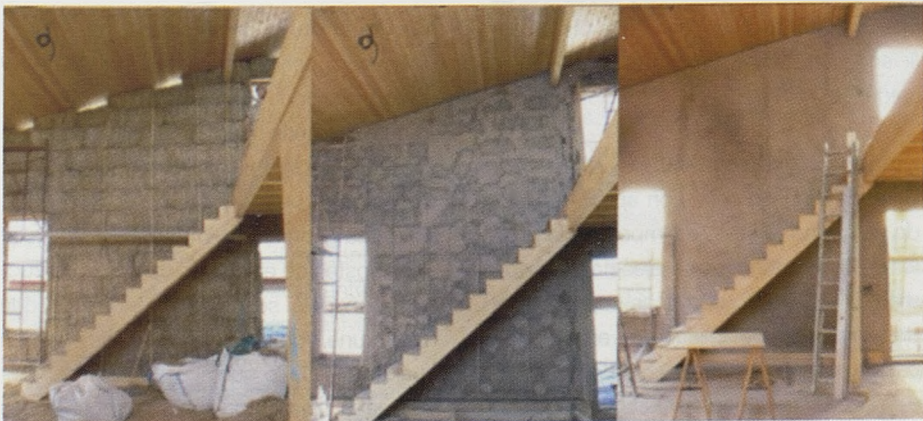
Diferentes capas de revoque. Grosor total aproximado de 3-6 cm
