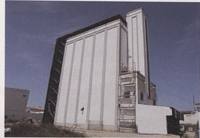
Reciente intervención Silo de Fuentes de Andalucía. www.fabricadearquitectura.es
