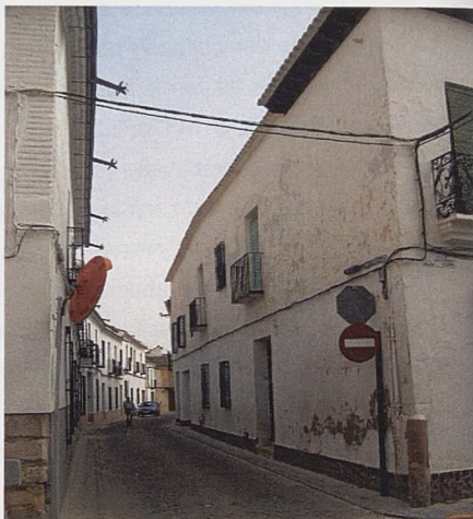
Fachada secundaria en Calle Carrascos
