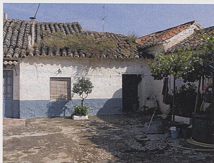
Interior de una vivienda realizada con técnicas de arquitectura popular
