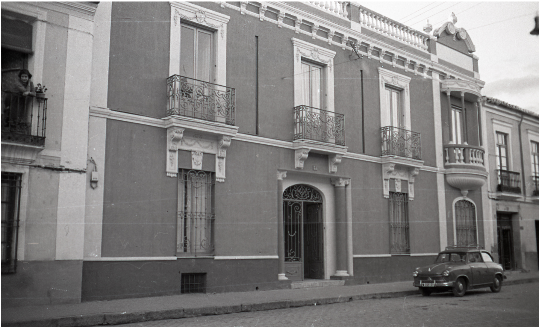
Calle Toledo (Edificio del Sanatorio Santa María del Prado). 8 de diciembre de 1958
