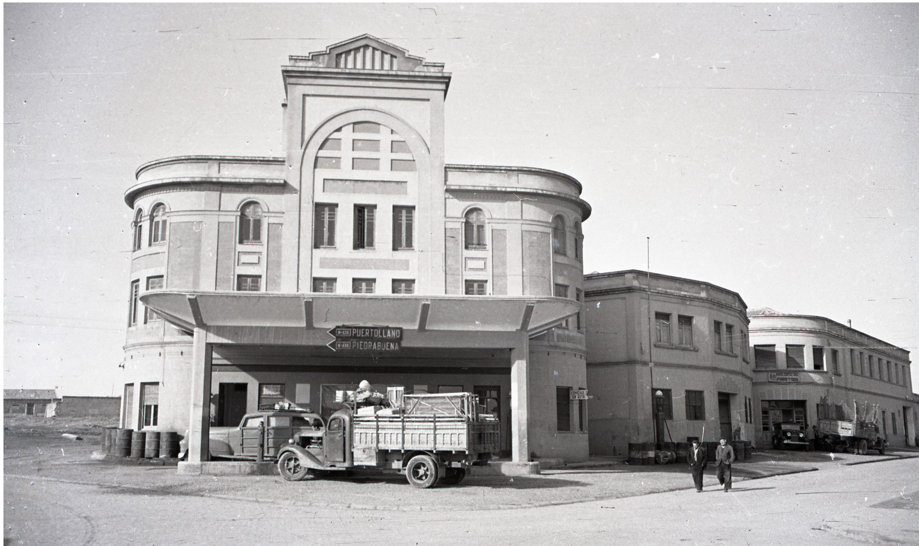
Ronda de Alarcos (Edificio Garaje Ford)
