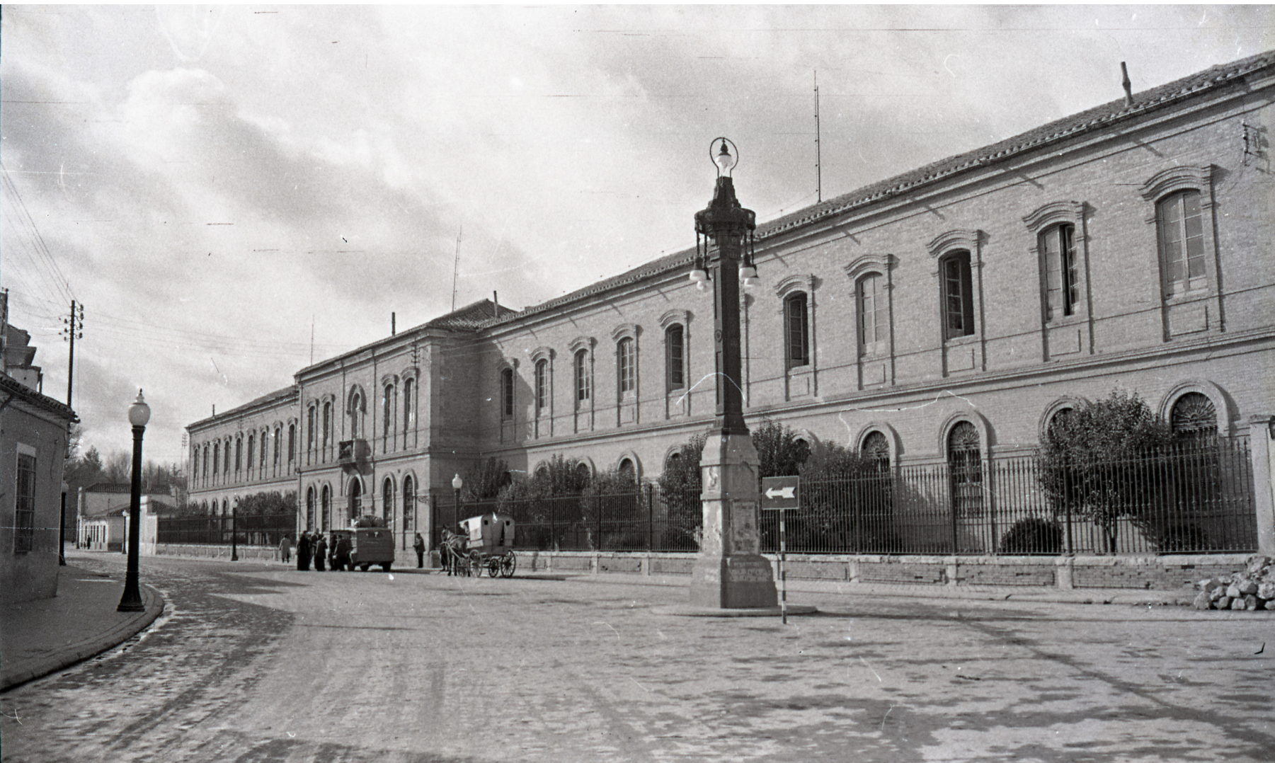
Calle Alarcos (Edificio del Seminario Diocesano)
