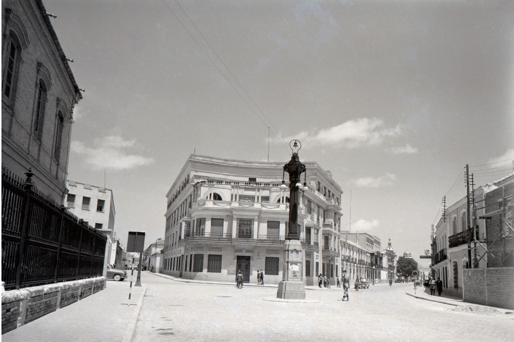
Esquina Calle Postas y Alarcos
