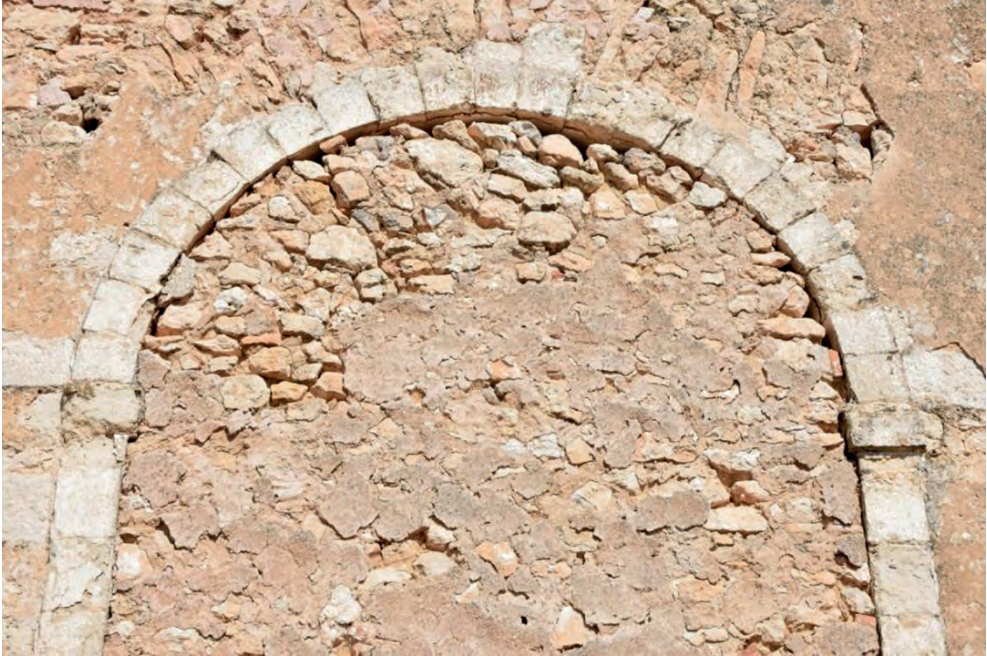
Fig. 5. Detalle de la parte superior de la portada tapiada de Villacentenos. Fuente: fotografía del autor
