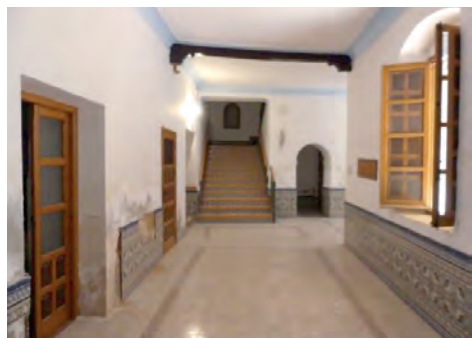
Galería planta baja Zona entrada
