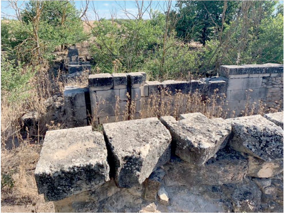
Fig. 6. Esclusa de Villacentenos. Canal del Gran Priorato de San Juan. Fuente: fotografía del autor
