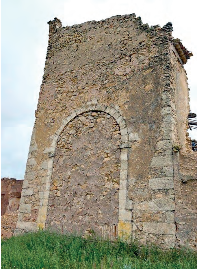
Fig. 1. Portada tapiada en Villacentenos, supuesta entrada a la antigua ermita o castillo del sitio Fuente: fotografía del autor
