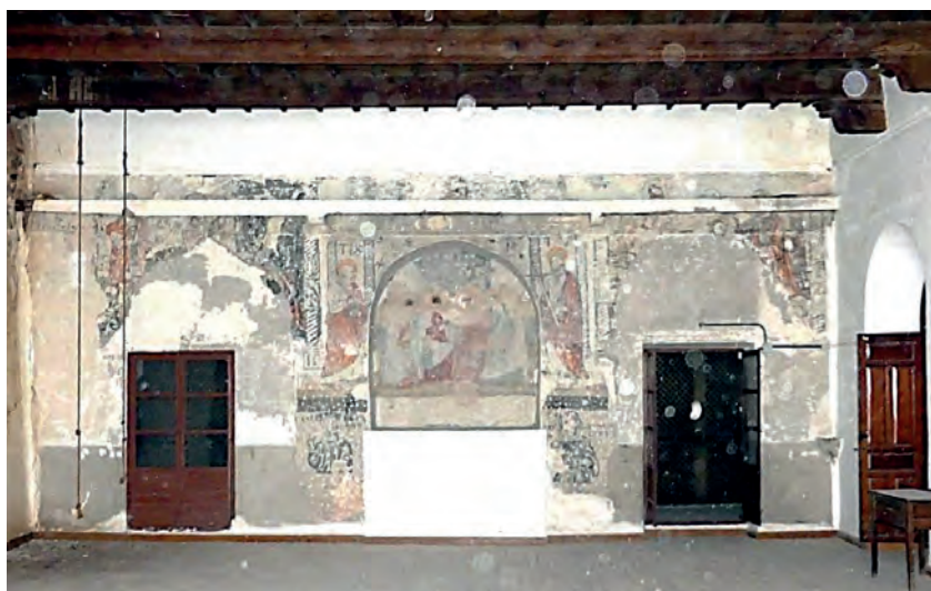
Pinturas del frente de la sala capitular de planta primera
