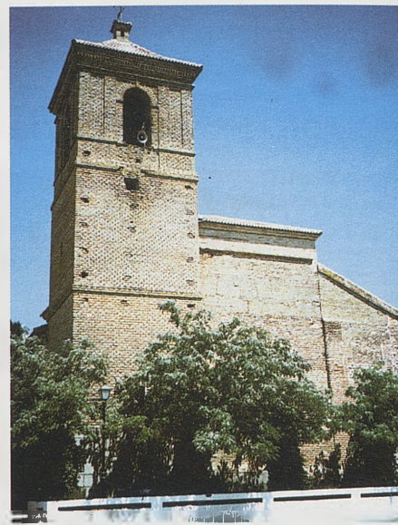
Sobre estas líneas, la Ermita de San Roque, patrón de El Casar de Escalona.
