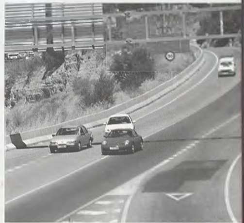
La autovía de Castilla-La Mancha, un gran proyecto para la región
