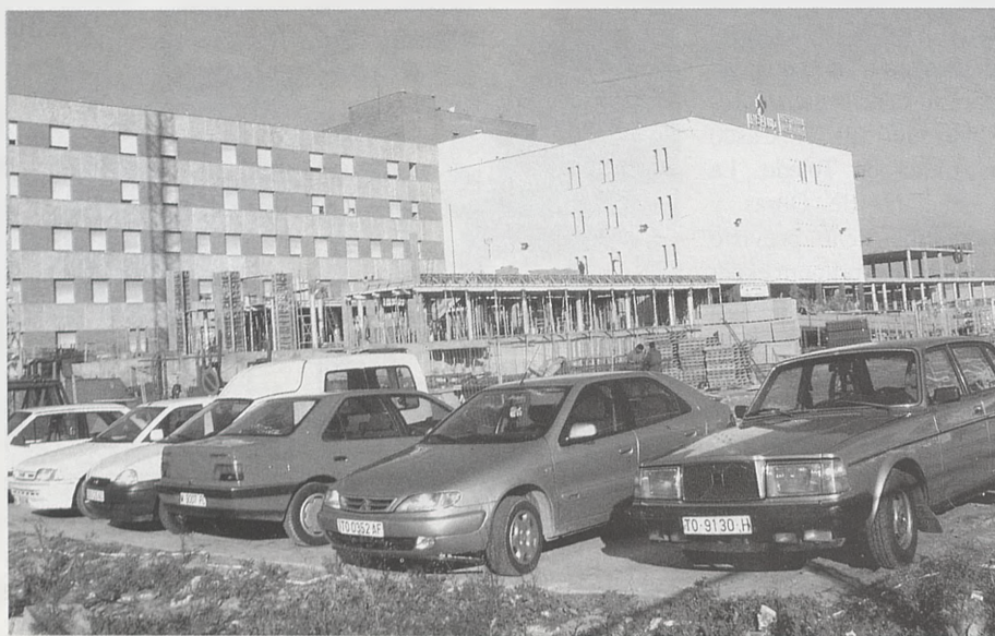
Las obras de ampliación del Hospital Nuestra Señora del Prado estará realizada, al 80 por 100, en enero del próximo año. Lo que irá en beneficio de los ciudadanos de Talavera y la comarca.
