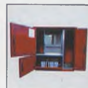
cableado, ensamble y prueba
