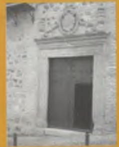
84 EDIFICIOS EN REHABILITACIÓN
