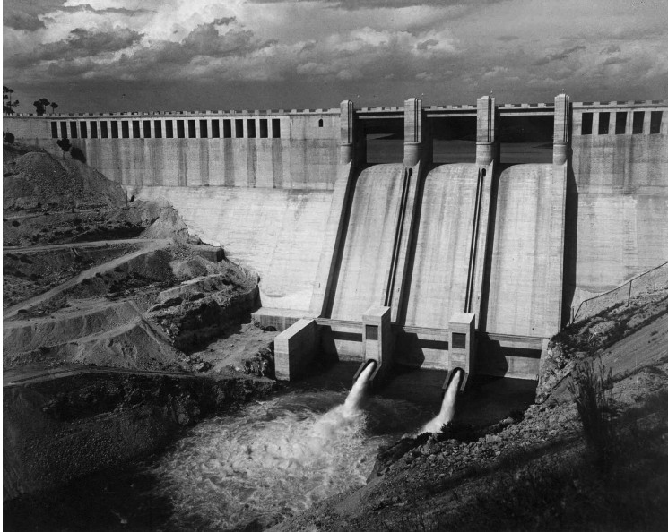
Vista de los aliviaderos y desagües de fondo.
