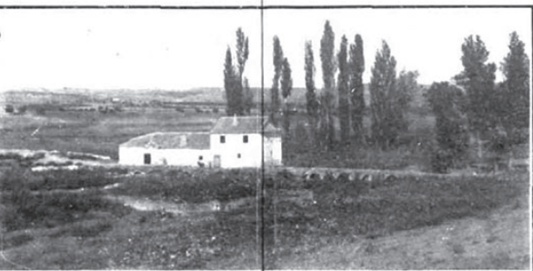
Vista panorámica tomada desde el puente. FOT. V. M. POLO COLASO
