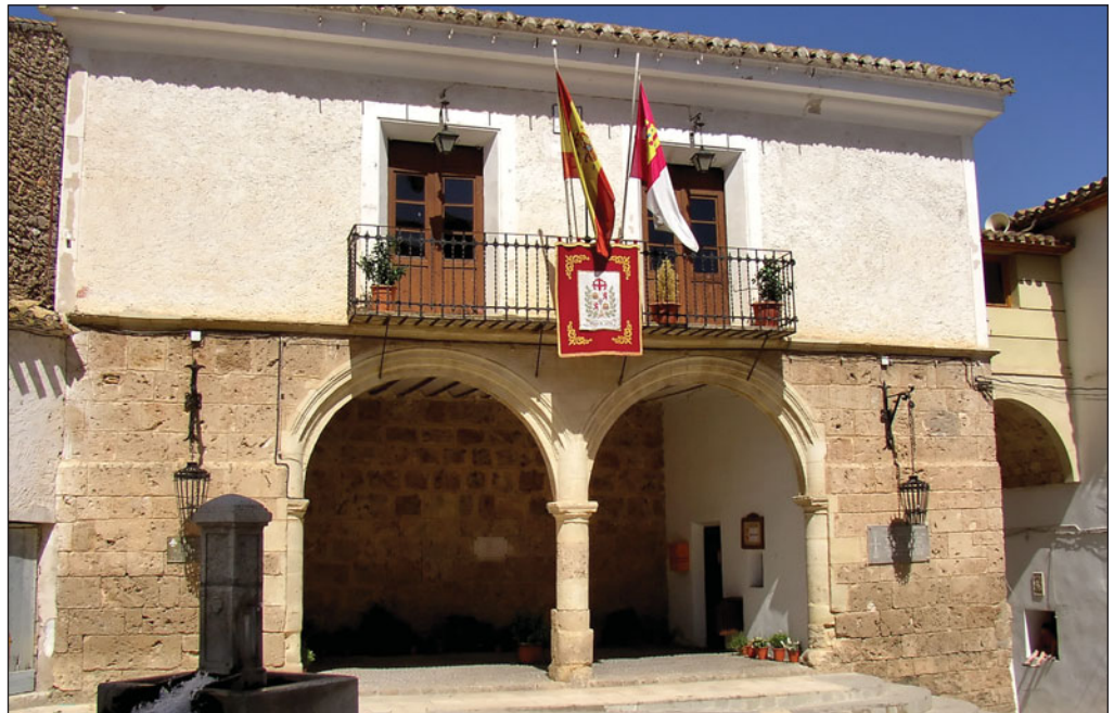
Fachada del ayuntamiento de Letur, del siglo XVI, ubicado sobre dos arcos renacentistas, con una balconada castellana.
