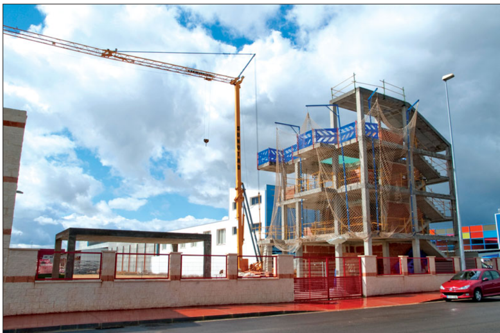
Centro de formación de la Fundación Laboral de la Construcción en el polígono Romica de Albacete.
