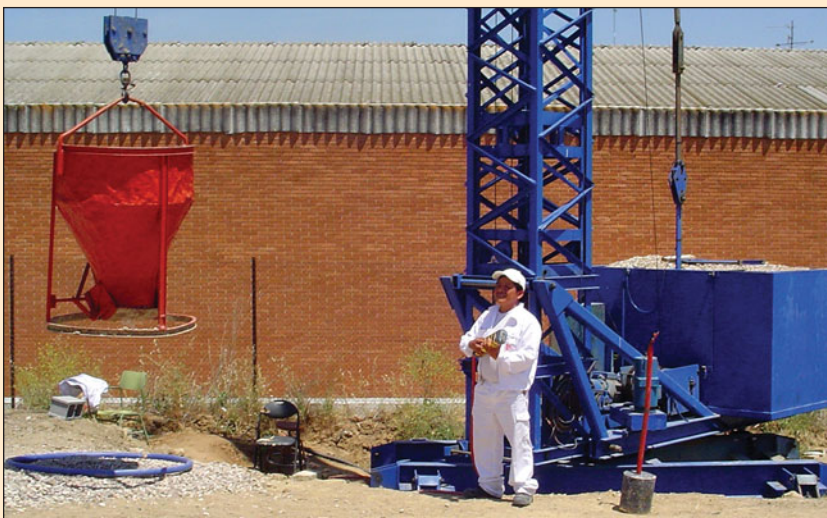
Con la Tarjeta Profesional de la Construcción se acreditan, entre otros, la formación y experiencia de los profesionales a los que le son de aplicación el Convenio General del Sector de la Construcción.
