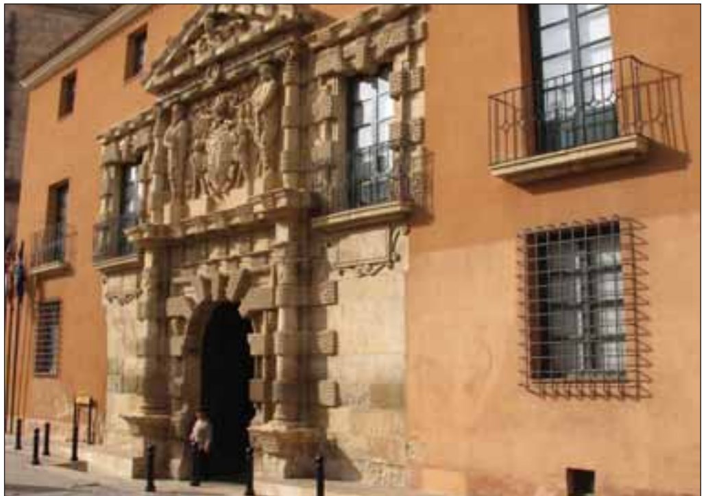
Casa Grande, sede del ayuntamiento de Almansa, uno de los edificios emblemáticos de la localidad.
