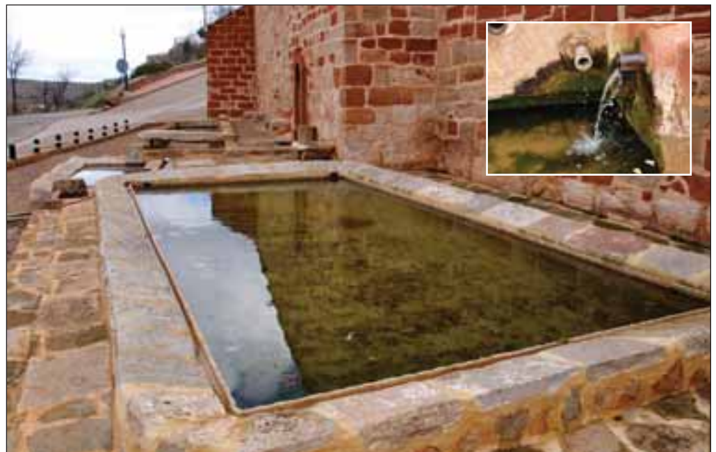
Fuente de Almedina. De origen románico y con modificaciones de la época árabe.
