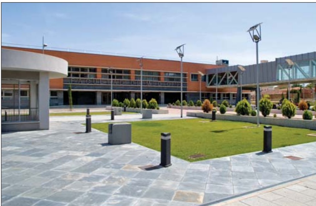
Facultad de Medicina de Castilla-La Mancha en Albacete, con la pasarela que la une al Hospital Universitario albaceteño.
