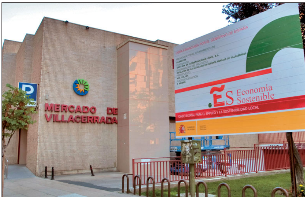
Otra de las obras del FEIL ha sido la impermeabilización de la cubierta del Mercado de Villacerrada. →
