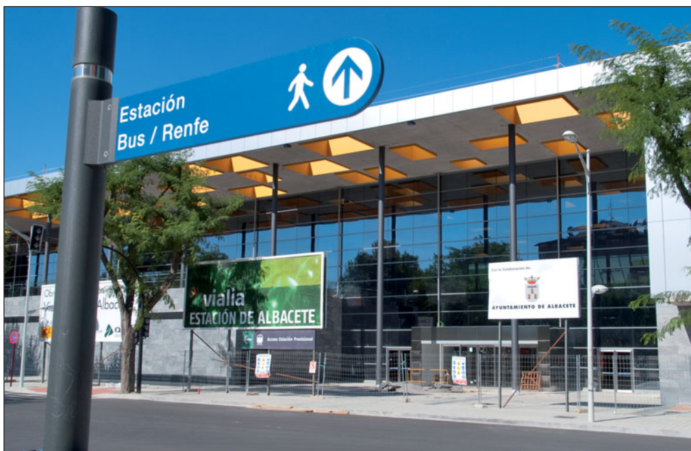
La nueva estación de Renfe en Albacete, en proceso de construcción, estará adaptada a las características del AVE.
