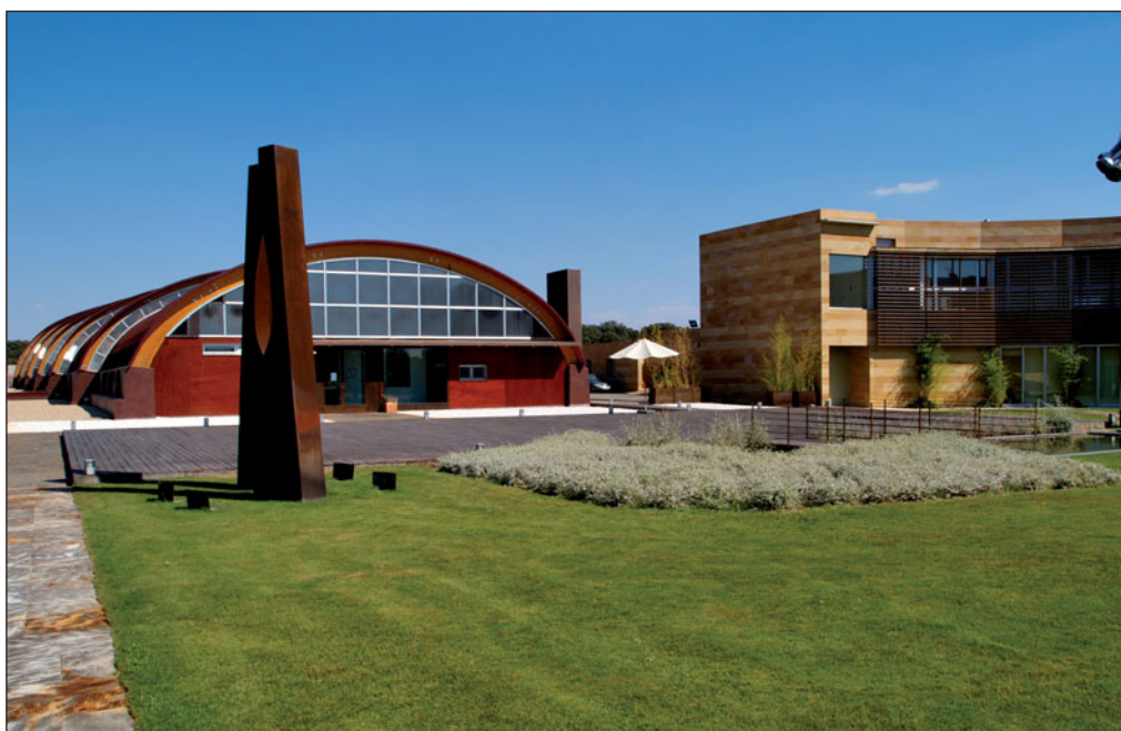
Complejo enológico en Bodega Pago del Vicario, en Ciudad Real. En la foto, Bodega, a la izquierda, y Hotel, a la derecha.
