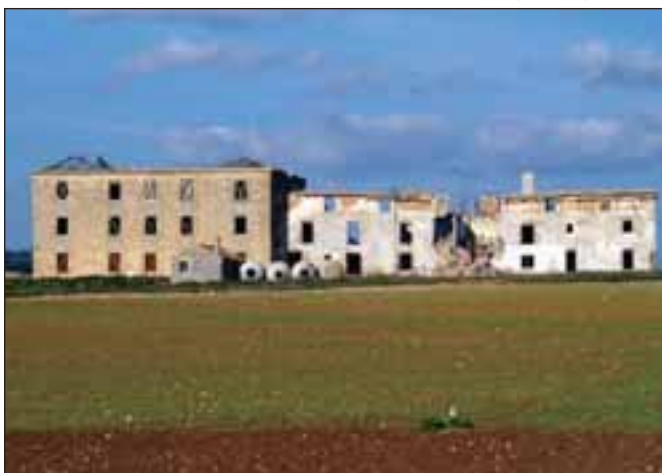
Restos de la Casa de la Encomienda en Villaescusa de Haro (Cuenca).
