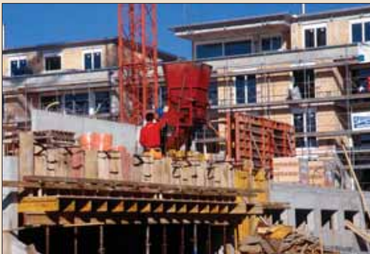
El boom inmobiliario está instalando un modelo territorial, urbano y constructivo que resulta mucho más pródigo en daños ecológico-ambientales que los previamente existentes.
