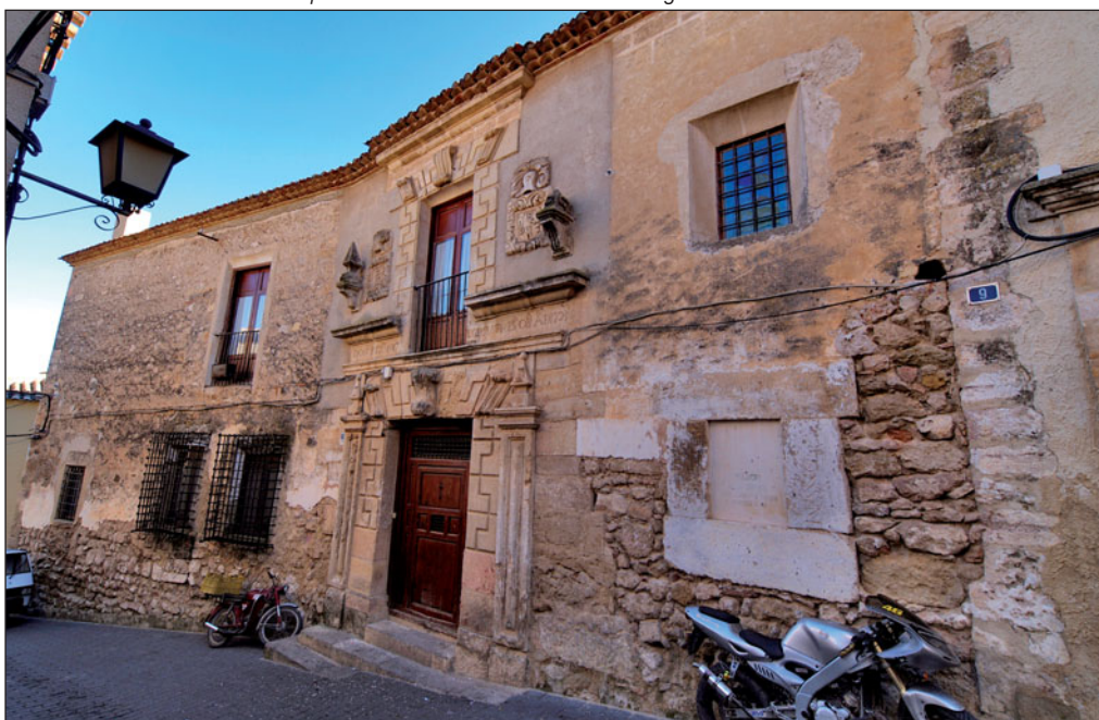
El Palacio de la familia Barnuevo posee una bella fachada barroca del siglo XVIII.
