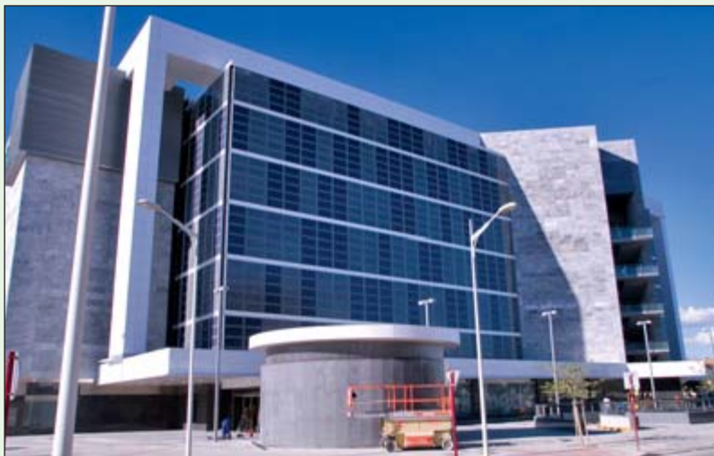
El nuevo centro dispone de módulos fotovoltaicos para producción de energía eléctrica limpia.
