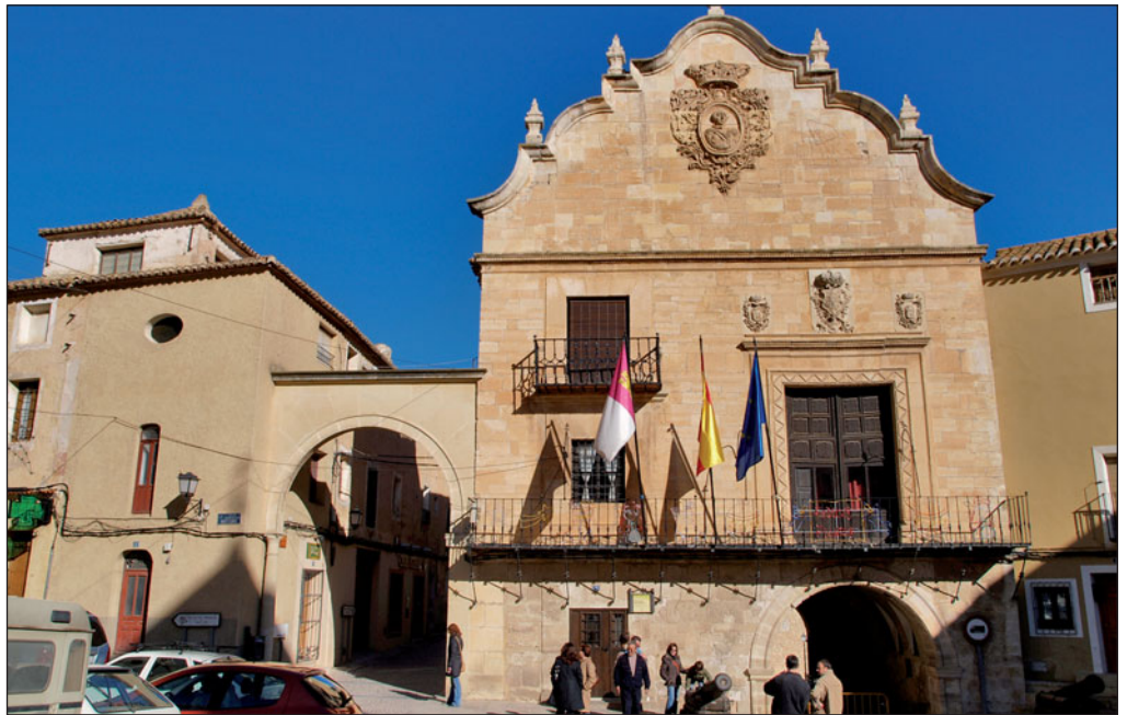
Fachada del ayuntamiento de Chinchilla en la Plaza de La Mancha de esta localidad.
