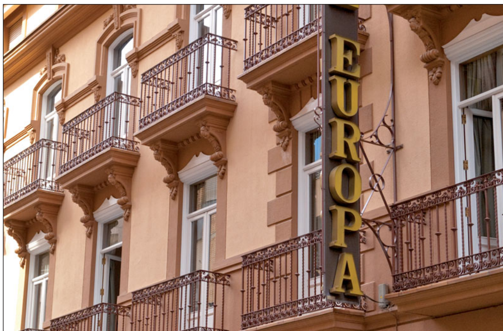
Fachada del edificio del Hotel Europa de Albacete.
